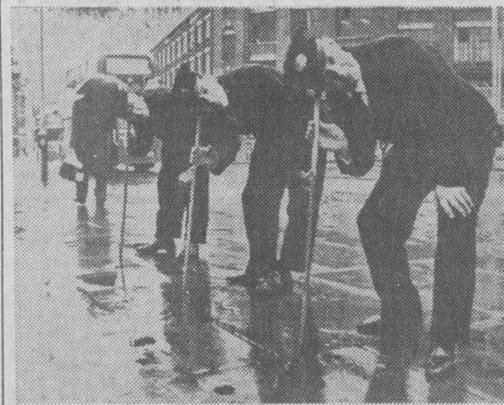
A pesar de las nuevas técnicas aún siguen utilizándose antiguos métodos en los más diversos servicios. Vemos en la fotografía a tres técnicos de la Comisión de Aguas de Londres tratando de detectar derrames o filtraciones en las tuberías tendidas bajo el pavimento. Utilizan lo que se llama «palo de sondeo», una fuerte vara de fresno con un articulador de madera de haya en un extremo. Ningún dispositivo electrónico ha conseguido superar a este sistema tradicional. — (Foto FIEL)
