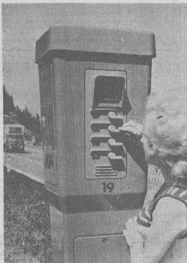
La autopista del puerto alpino del Brenner, en Alemania, ha sido equipada con un sistema ultra moderno de alarma: una red de 40 puestos para la petición de ayuda, por valor de 400.000 marcos, que poco a poco será instalada en todas las autopistas alemanas con tráfico internacional. Cada puesto tiene cuatro palancas, señaladas con símbolos para su mejor comprensión. Con sólo bajarlas se puede solicitar socorro médico, ayuda de la policía, mecánicos, etc. Es un sistema electrónico que sirve también para la vigilancia de las carreteras, advirtiéndolo automáticamente los peligros por nevadas, nieblas, etc., supervisando las señales y controlando la circulación. — (FOTO-FIEL)
