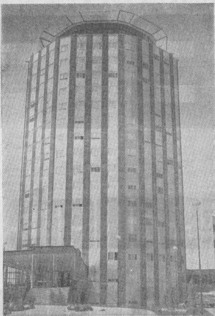
Muy próximamente, la clínica de la Paz, de Madrid, inaugurará su sección de maternidad, con capacidad para cuatrocientas ocho camas y atendida por diez equipos de toxicología. Pero la novedad será el helipuerto, situado en la cubierta de la torre del edificio, donde podrán aterrizar helicópteros con enfermos de urgencia. — (Foto Hispania Press).
