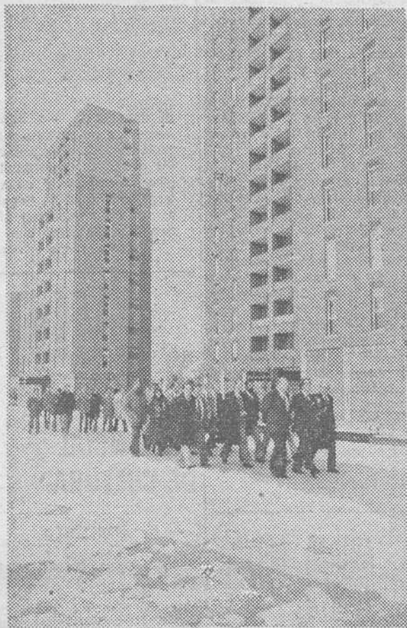
Un momento de la visita a las viviendas de la urbanización "Río Vena" — (Foto FEDE)
