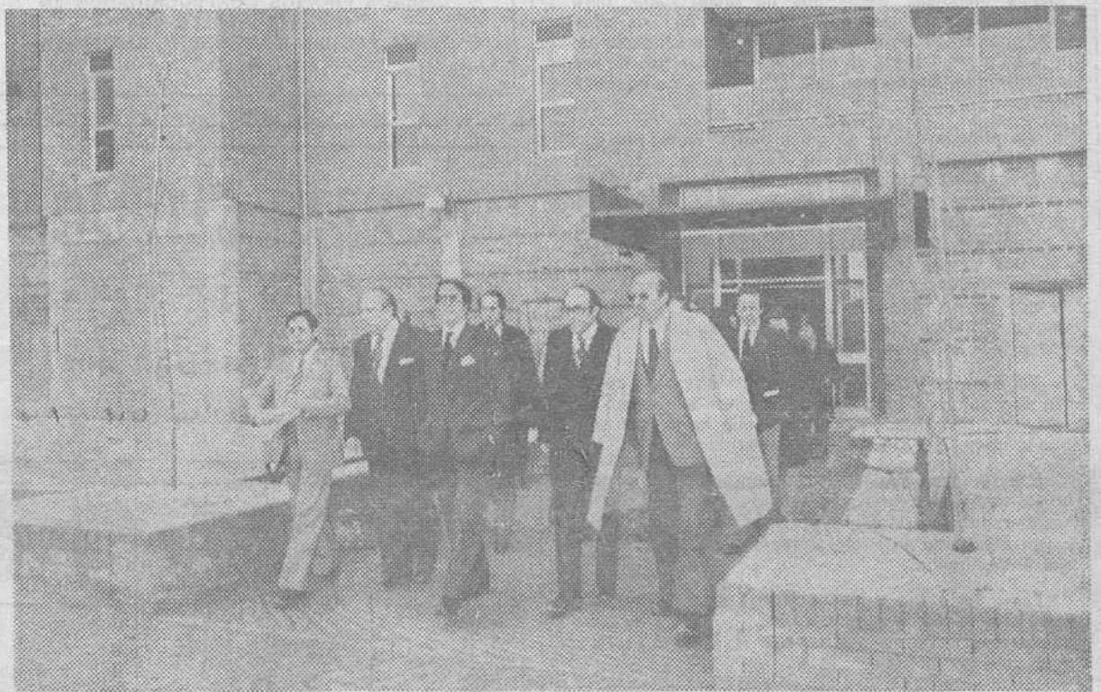
Durante su estancia en Burgos, el ministro de Obras Públicas y Urbanismo, señor Garrigues Walker, visitó la urbanización "Río Vena", situada dentro del polígono "Carrero Blanco". — (Foto FEDE)
