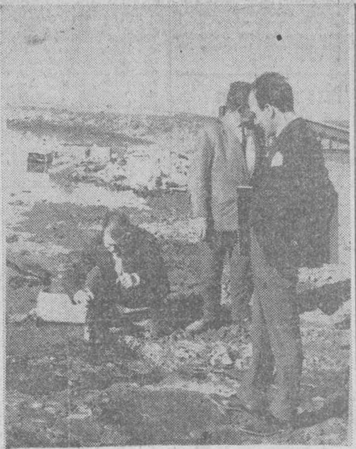
"Fede" obtuvo ayer las precedentes placas, en el recinto petrolífero de Valdeajos. En la primera aparecen los obreros trabajando en las tareas de perforación, que prosiguen ininterrumpidamente. En la segunda nuestro redactor jefe, señor Ruiz Valderrama recogiendo, a presencia del secretario de Sala de esta Audiencia don Juan Molina y del artista Jesús del Olmo, en un pequeño recipiente, muestra del primer petróleo aparecido en España, recuerdo de este memorable hallazgo que DIARIO DE BURGOS conservará como testimonio de valor único para la Historia de Burgos.
