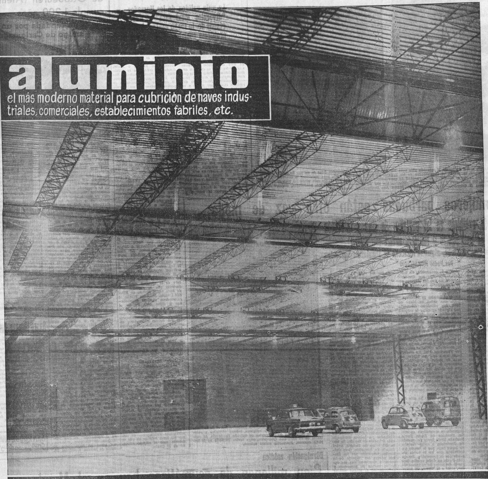
Interior de la nave-cochera de 2.700 m<sup>2</sup>, para los autobuses urbanos de Valladolid, de la Empresa Carrión, con cubierta en aluminio de «ALCAN», Aluminio Ibérico, S. A. — montaje y estructura de esta cubierta realizada por CUYES, S. L.
