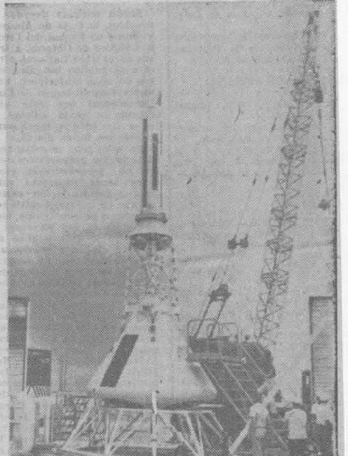
Los ingenieros espaciales norteamericanos han iniciado las pruebas del sistema eyector de salvamento del Proyecto Apolo, para salvar la cápsula y a sus tripulantes en caso de avería del motor en el momento del lanzamiento. He aquí la cápsula y la torre de escape, listas para el lanzamiento.
