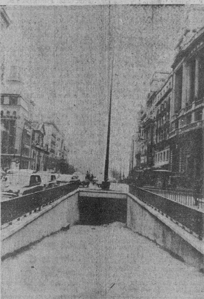
Uno de los accesos al aparcamiento subterráneo de automóviles que está a punto de ser terminado en la calle de Sevilla, en Madrid, y que aliviará el problema cada vez más difícil del aparcamiento en el centro de la capital.—(Foto Fiel)
