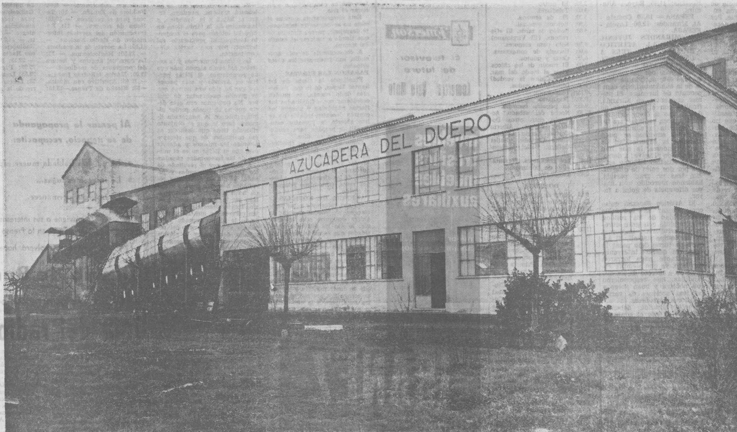
Difusión de la casa danesa "De Danske Sukkerfabrikker" instalada por su licenciataria en España S. A. JULIANA CONSTRUCTORA GIJONESA en Azucarera del Duero.
