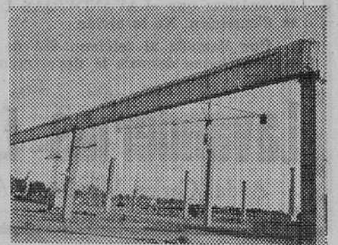
VIGA COLOCADA EN SU DESTINO
