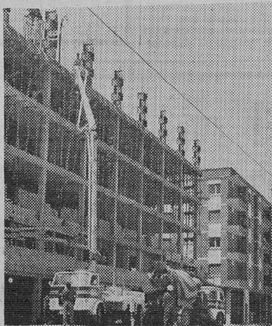
Bomba hormigón para colocar hormigón donde se necesite
