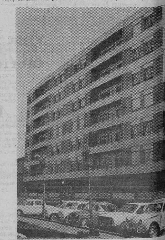
Fachada de un moderno edificio en construcción la Plaza de Primo de Rivera. —(Foto Díaz)
