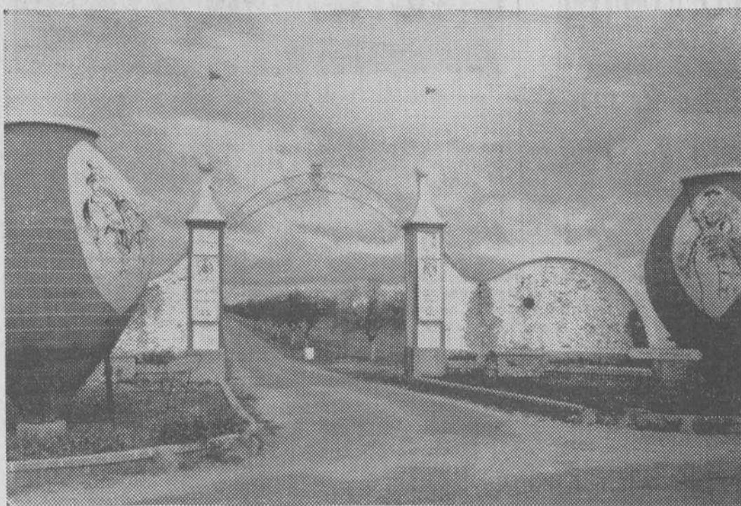
Esta es la puerta, sin rejas, a campo libre de la Penitenciaría de Herrera de la Mancha, en la provincia de Ciudad Real, colonia agrícola singular que, fertilizada por la afluencia de las aguas ocultas del Guadiana, da trabajo y redime penas a unos cuantos reos, que pasan todo el día en la más absoluta libertad. Se dice, con razón, que es una de las cárceles más generosas del Mundo. En su entrada, como se ve, hay dibujadas en panzudas tinajas manchegas las figuras de D. Quijote y Sancho Panza. — (Foto FIEL)
