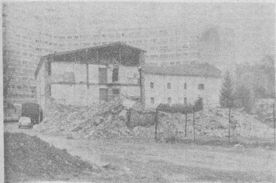
Se han hecho algunos derribos en el polígono Sur de Reyes Católicos de cara a futuras construcciones recientemente aprobadas por el Ayuntamiento. En la fotografía les mostramos una de ellas, de una edificación que se encuentra junto al viejo Cuartel de la Guardia Civil, en "El Morco" — (Foto FEDE).
