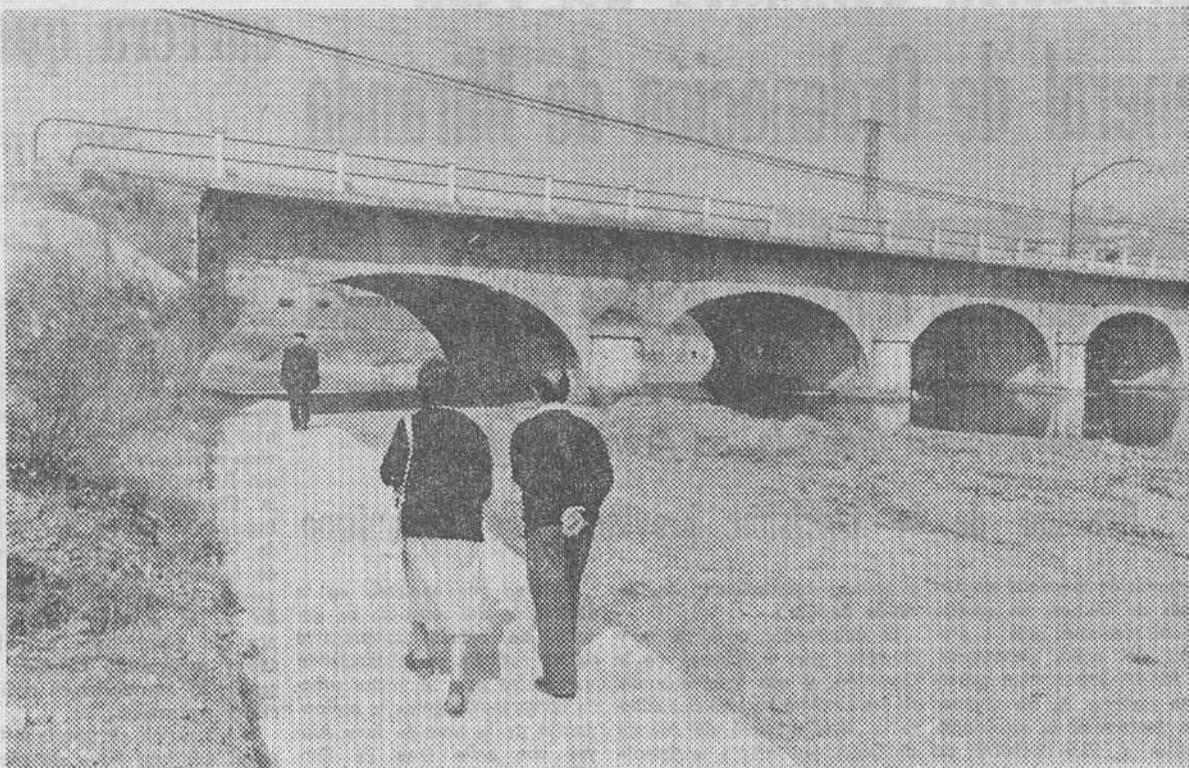
Este es el paso peatonal que ha construido la brigada de obras del Ayuntamiento en el puente de Capiscol para evitar atravesar la via férrea, «punto negro» por el elevado número de accidentes mortales que a lo largo de bastante tiempo se han registrado. El paseo peatonal y el puente elevado no justifican ya, en modo alguno, invadir el paso del tren. — (Foto FEDE).
