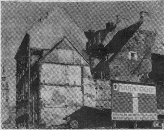
Junto a las obras de derribo de unas viejas casas de la ciudad de Munich el cartel indica que la urbe se moderniza y que en el futuro será más hermosa. Sin embargo hay quien ahora la existencia de estos antiguos edificios y lamenta su destrucción. (Foto FIEL)
