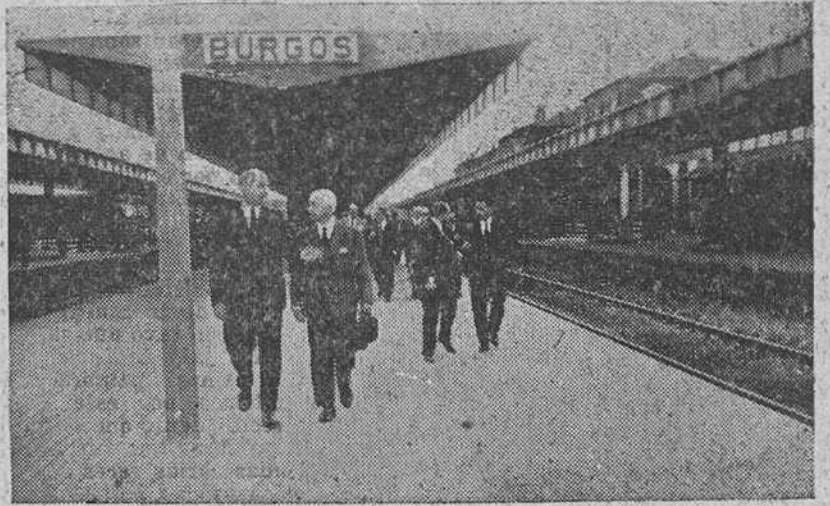
En el grabado superior, momento en que se formalizaron los documentos de entrega y recepción oficial de la obra, ya concluida, de la "Estación común" de Burgos. Previamente las personalidades y técnicos de Obras Públicas, de la RENFE y de la empresa constructora efectuaron una inspección a las instalaciones y servicios, cuya visita recoge la imagen inferior. — (Fotos FEDE)
