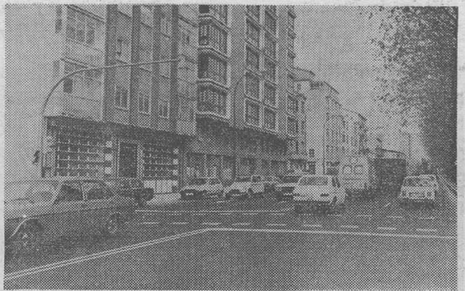
Ayer se abrió al tráfico en doble circulación un tramo de la calle Vitoria que ha sido objeto de mejora. He aquí la moderna calzada con el tránsito rodado en los dos sentidos. — (Foto FEDE)
