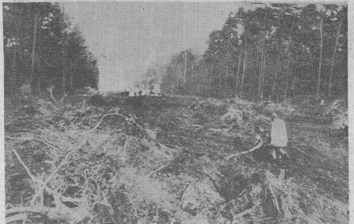
Francfort (Alemania Federal). — Trabajos para la construcción de la nueva autopista al aeropuerto de Francfort, que está provocando masivas acciones de protesta por parte de muchos ciudadanos, así como choques con las fuerzas de orden público. — (Telefoto Efe-AP)
