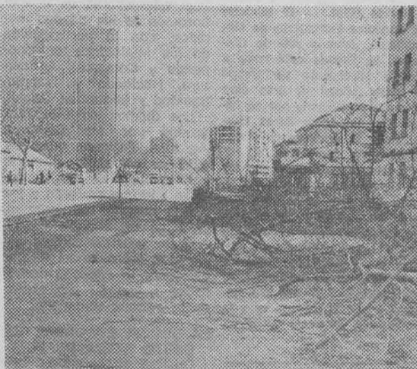
Varias decenas de árboles han comenzado a ser talados al iniciarse las obras de la travesía de la N-1, tema que ha provocado protestas y posturas controvertidas, que fueron abordadas en la reunión de ayer tarde, en la Casa Consistorial. A la derecha, hace siete años y en previsión, acaso, de esta corta, se plantaron otros retranqueados, a la altura de la nueva Barriada Militar. (Foto Fede).
