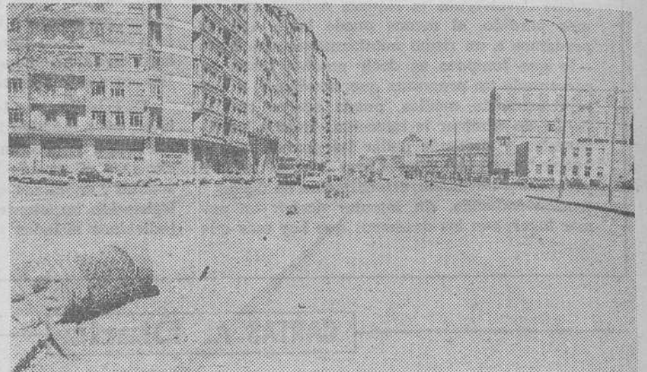
Se ha depositado el material necesario para colocar cortapasos en la avenida de Vigón, según acuerdo adoptado por el Ayuntamiento. Irán en la mediana con el fin de evitar que se atravesara la calzada por aquellas zonas donde no haya pasos de peatones. (Foto FEDE)
