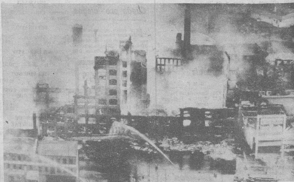
Lynn (Estados Unidos). — El domingo se desencadenó en la ciudad norteamericana de Lynn un violento incendio que pudo ser controlado tras dieciséis horas de trabajos continuados de los bomberos. Por el momento se desconocen las causas que motivaron el siniestro, que obligó a más de doscientas personas a evacuar rápidamente sus hogares. En la foto, vista general del incendio, mientras es sofocado por los bomberos (TELEFOTO EFE)
