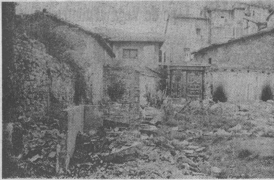
La foto de Juan Muro, nos muestra el estado que ofrecen actualmente los terrenos donde en otro tiempo existió una fábrica de mosaicos y otras edificaciones, entre las calles de Real Allende y Arrenal, en uno de los lugares más céntricos de la ciudad. El problema radica, además del feo aspecto que estas ruinas ofrecen, en que al no estar valladas, penetran en las mismas auténticas bandas de mozalbetes, que se dedican a realizar toda clase de tropelias —hacen hogueras, arrojan piedras contra las casas cercanas, etc., etc.— y naturalmente, corren el riesgo de romperse la cabeza entre las ruinas citadas. No estaría de más, pensamos, que los propietarios de estos terrenos, mientras que llega el día de darles una utilidad, los dotaran de vallas.
