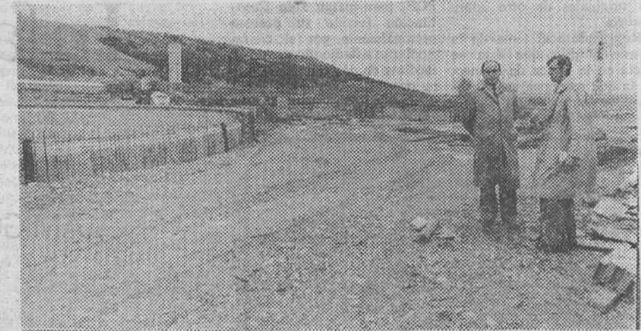
El alcalde, concejales, técnicos e informadores visitaron ayer las obras de la estación depuradora de aguas residuales de Villalón. — (Foto FEDE)
