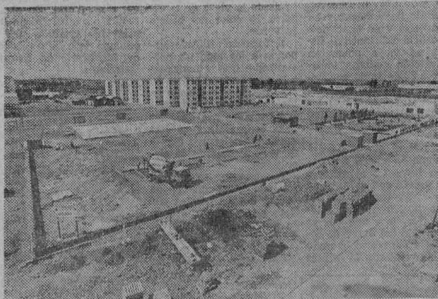
Aspecto de las obras del parque y polideportivo municipal de Santa Catalina, en donde se aprecia ya la construcción de una pista, foto tomada a los ocho días de dar comienzo las obras, lo que indica el ritmo que se lleva.
