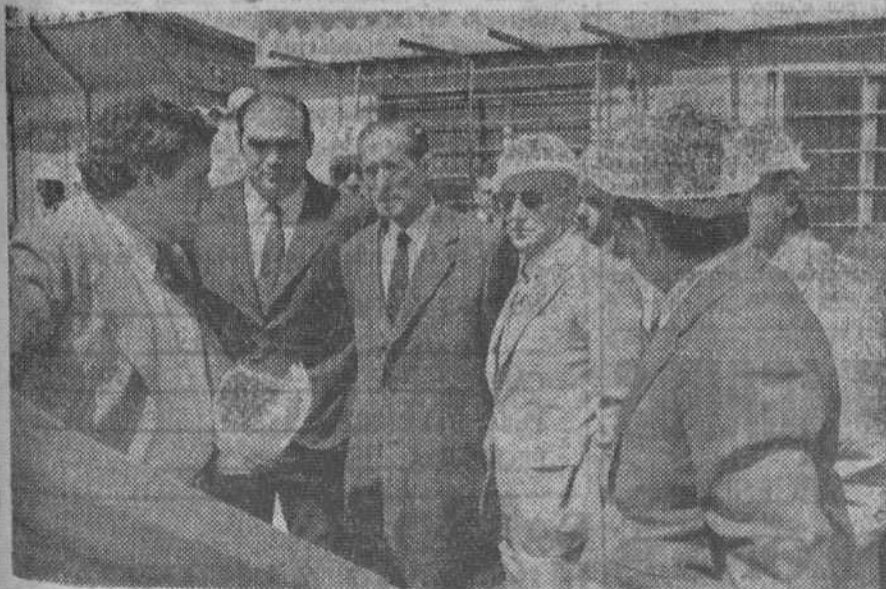
Un momento de la visita efectuada a las obras de la nueva planta en el Polígono de Gamonal. — (Foto FEDE)
