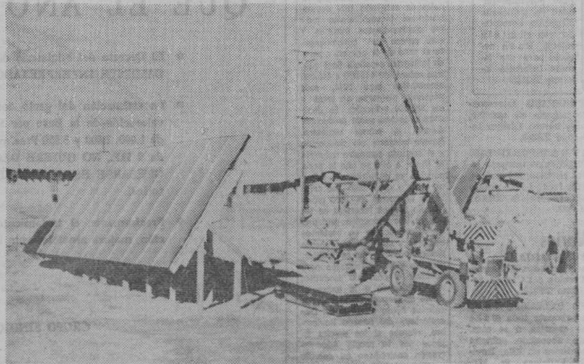
Hawthorne (Nevada).— Un sistema para recoger calor del Sol se está experimentando en el depósito naval de municiones de Hawthorne. Las placas recogen el calor de los rayos de Sol para calentar agua que, a través de tuberías van a un depósito subterráneo y de éste a las casas que utilizan el sistema para calefacción. El depósito subterráneo tiene capacidad para agua suficiente para calentar una casa durante tres días. — (Telefoto Cifra Gráfica-UPI)
