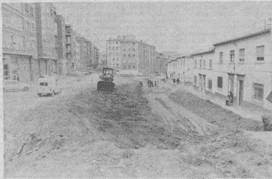
Este es el aspecto que ofrecía ayer la calle del Romancero tras comenzar las obras de urbanización de una de las vías urbanas que sufrirán una profunda transformación con este proyecto. — (Foto FEDE)
