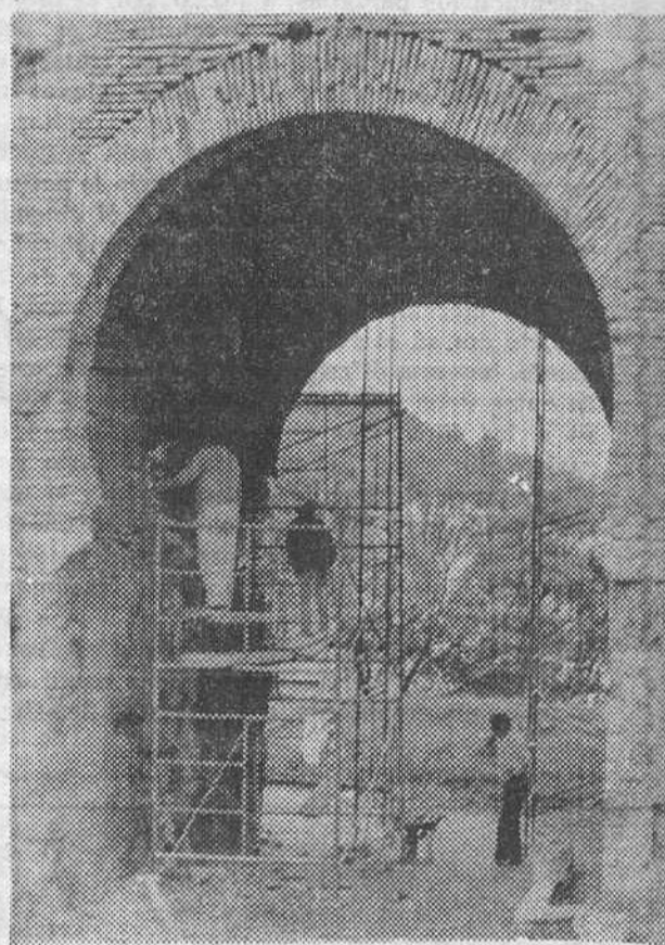
El magnífico arco mudéjar de San Esteban, está siendo objeto desde ayer, de diversas obras de consolidación y de posterior restauración. La fotografía de «Fede» recoge un momento de los trabajos en el interior del histórico arco.
