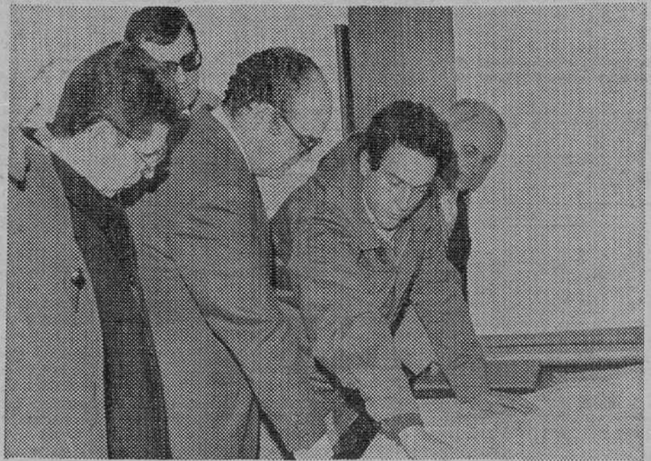
El arquitecto director de las obras, D. Carlos Mart nez, explicando a los subdirectores generales, sobre el plano, la parte de obra que falta por ejecutar. (Foto FEDE)
