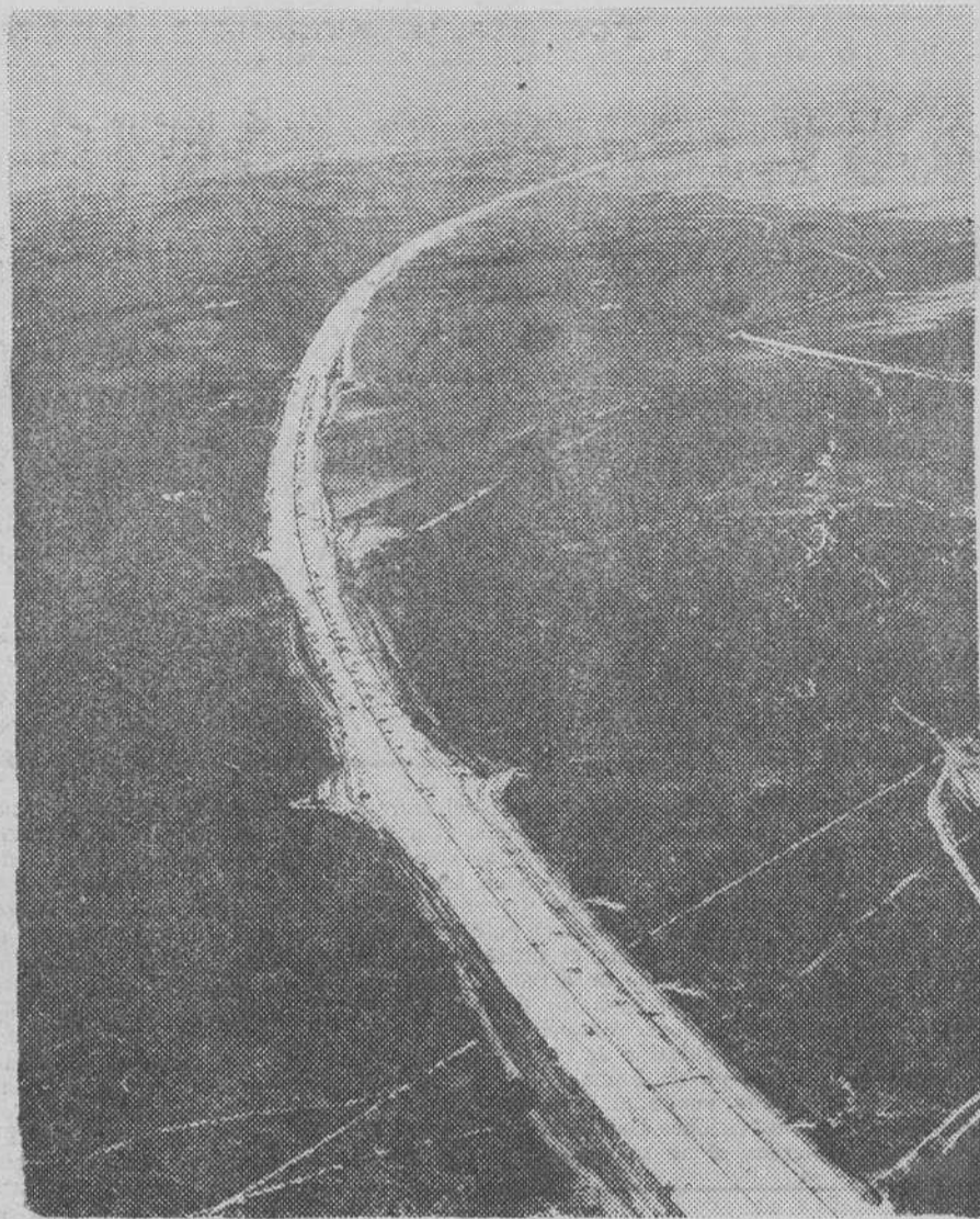
Una de las áreas de servicio de la autopista de peaje Cádiz-Sevilla
