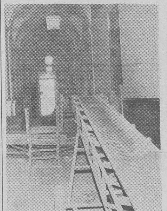
Madrid.— Las obras del palacio de las Cortes, de Madrid, van a ritmo acelerado. Aprovechando el verano y las vacaciones, un arreglo del edificio vendrá muy bien para la próxima temporada de frío y lluvias.
