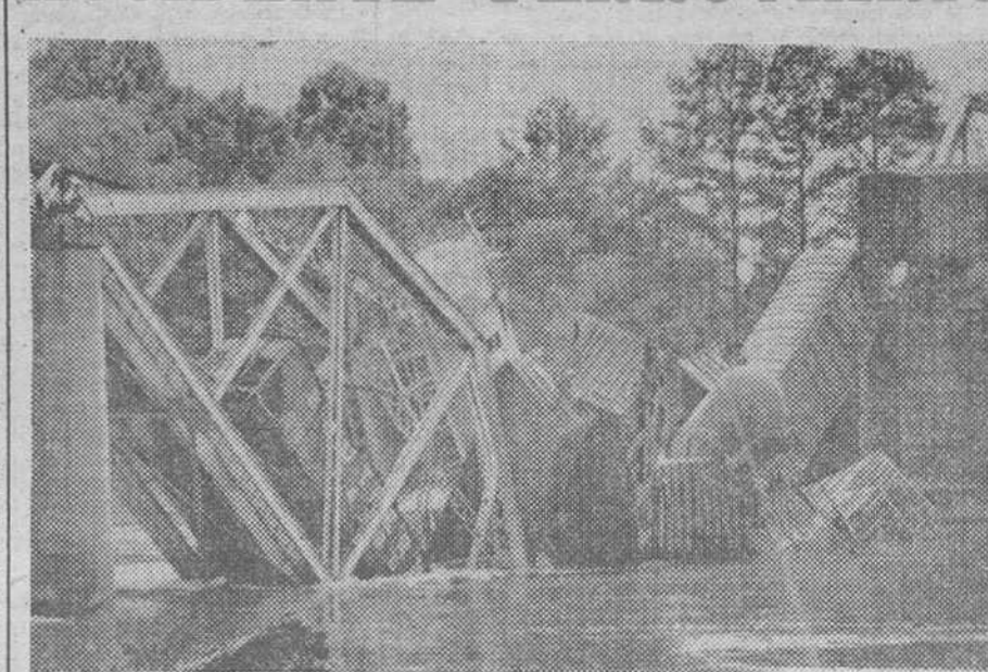
Childersburg. — Veinte vagones de un total de 76 de un tren de la Seaboard Coastline Railroad cayeron en el Coosa River Boar Childersburg, Alemania, después de que una parte del puente se hundiera. Cerca de 75 personas que pasaban sus vacaciones cerca del río fueron evacuadas de sus casas y de sus rulots debido a la posibilidad de un escape de gas del tanque de gas butano suspendido del puente. (Telefoto UPI-CIFRA-GRAFICA)
