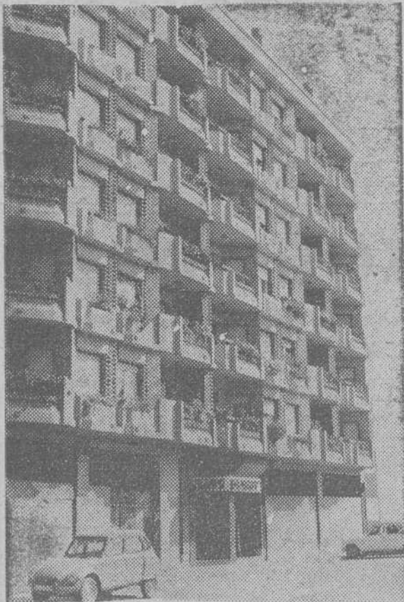
Moderna edificación de la calle de Santiago, de Aranda de Duero. — (Foto Reyes).
