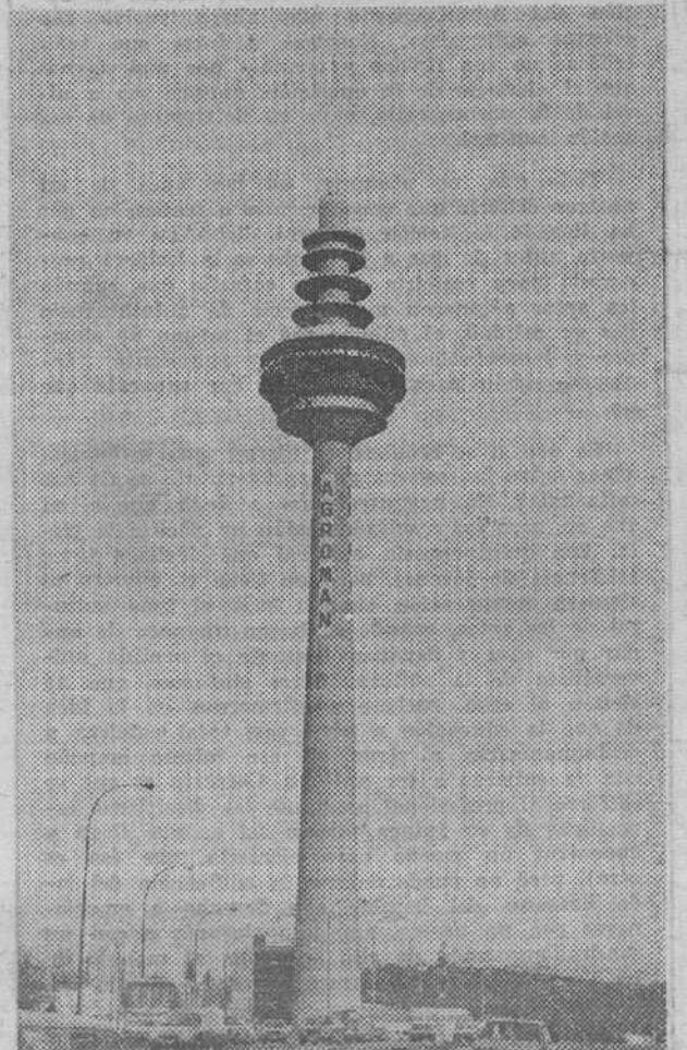
Madrid. — El miércoles fue presentada a los medios informativos la torre de RTV. E. en Madrid, construida por Dragados-Agromán para su utilización como centro nodal de la red nacional de radioemisiones, así como punto de base para las retransmisiones de los enlaces móviles de Madrid. La torre, que alcanza la altura de 220 metros, está situada junto a la autopista M-30 y las calles O'Donell y Sainz de Baranda. El proyecto se aceleró y puso en marcha aprovechando la celebración del Campeonato Mundial de Fútbol 1982 en España. — (Foto EFE).
