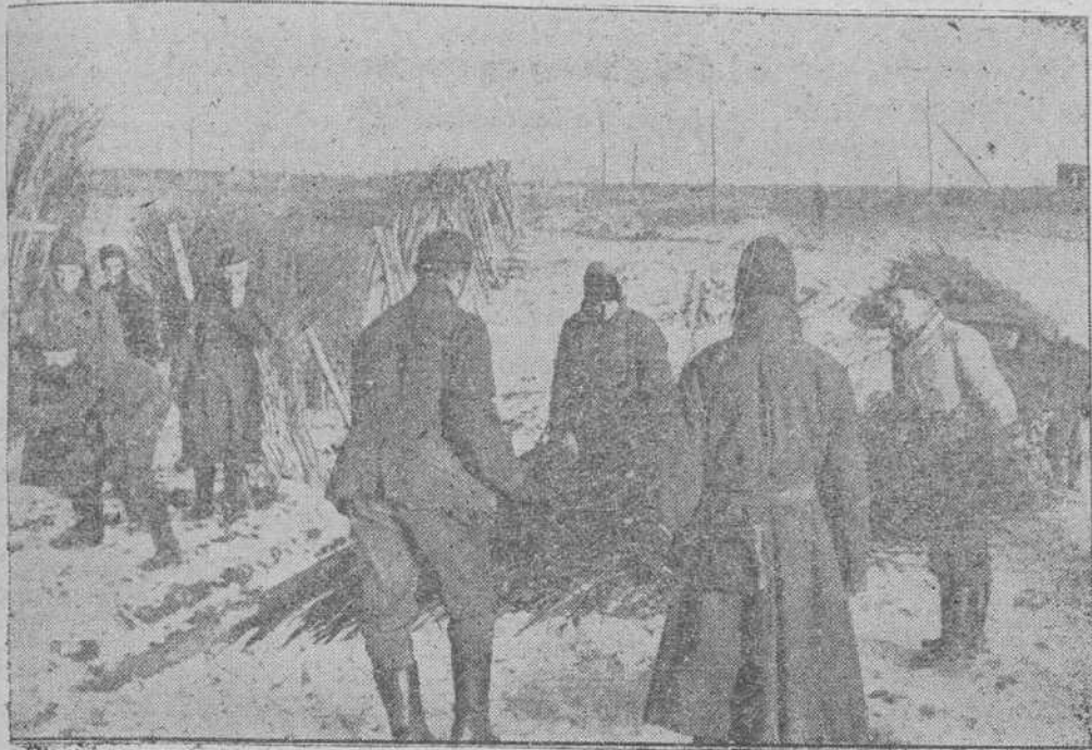
A lo largo de las carreteras de comunicación de los alemanes en Rusia, los Batallones de Construcción alemanas emplazan empalizadas especiales para proteger estos del viento frío y de la acumulación de nieve arrastrada por los vendavales
