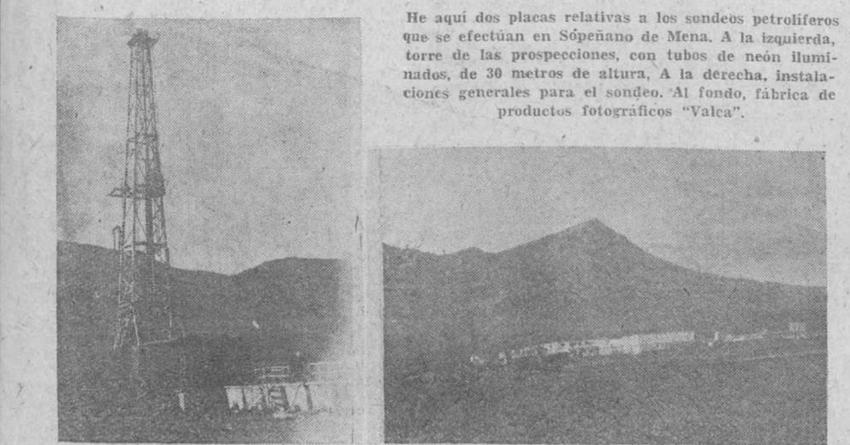
He aquí dos placas relativas a los sondeos petrolíferos que se efectúan en Sopenano de Mena. A la izquierda, torre de las prospecciones, con tubos de neón iluminados, de 30 metros de altura. A la derecha, instalaciones generales para el sondeo. Al fondo, fábrica de productos fotográficos “Valca”.
