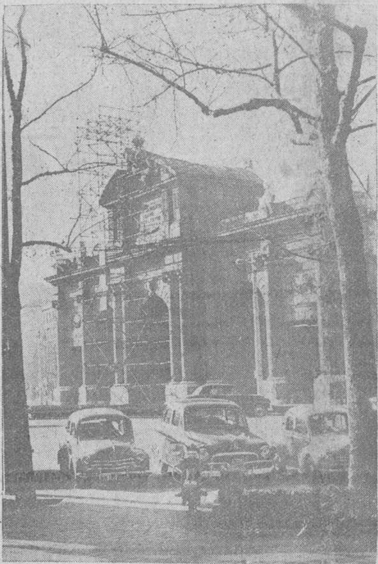
Madrid.—Junto a la Puerta de Alcalá pueden verse los andamiajes metálicos, primera señal de su restauración, que dará comienzo próximamente con un presupuesto de 150.000 pesetas. (Foto Gil del Espinar)
