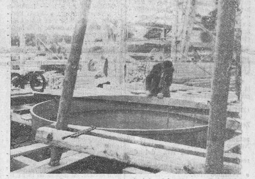
Zurich. — Para la conferencia sobre las aplicaciones de la energía atómica que habrá de celebrarse en Ginebra, los Estados Unidos han empezado a construir, junto al Palacio de las Naciones un reactor atómico que podrá ser visitado, durante la conferencia, y que posiblemente sea luego adquirido por Suiza. La foto muestra las obras para la instalación del reactor atómico. — (Foto Cifra)
