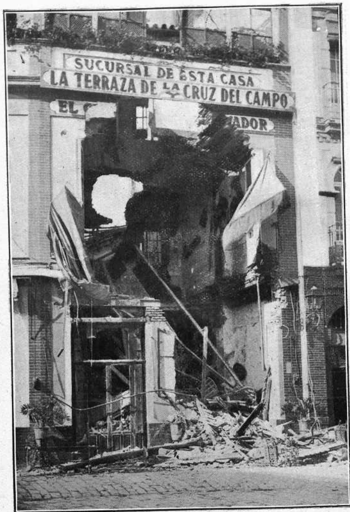
"La alegría de la República".—Estado en que quedó la Casa de Cornelio, de Sevilla, después de ser bombardeada por la dictadura republicana.
