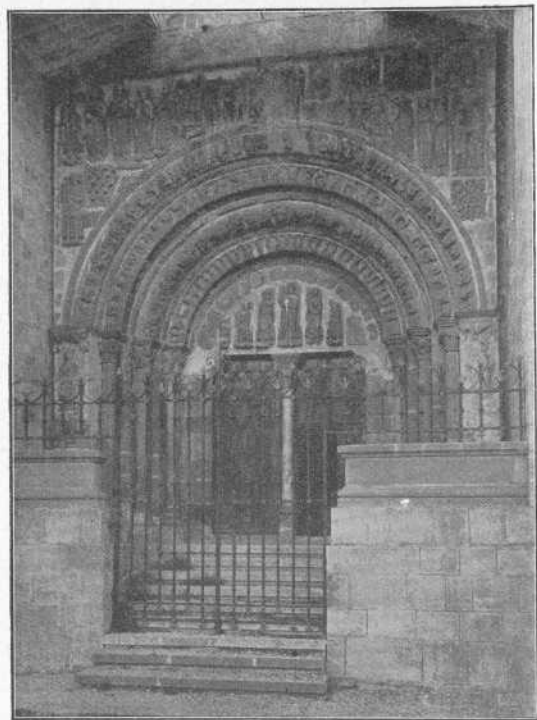
Fot. F. de las Heras
