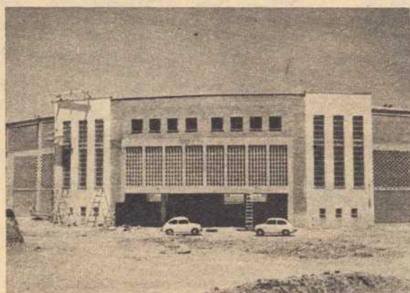
ENTRADA PRINCIPAL y fachada. Los espacios con cristales corresponden a la escalera que conduce a los palcos.
