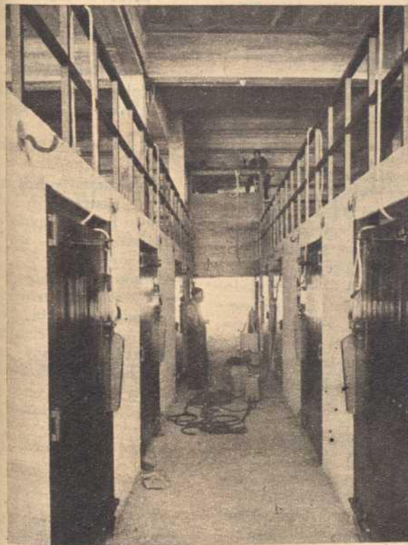
TORILES. Perfectamente puede observarse la magnificencia de estas instalaciones, en consonancia con las del resto de la plaza.
