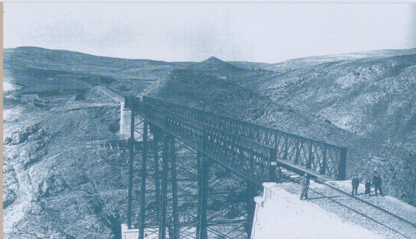
Viaducto de hierro sobre el río Gormayo, 1892
