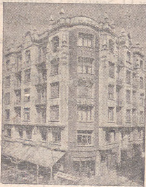
Oficinas Centrales: Espolón, 32 (Entrada por el Hondillo)
