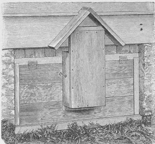
Fig. 140 POSTIGO DE SÓTANO, COLOCADO
