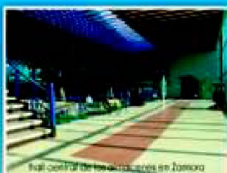
hall central de transformadores en Zamora
