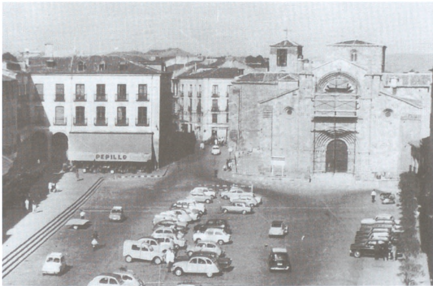
Retirada del rosetón de San Pedro. Tal vez no resistió las voladuras efectuadas para realizar el aparcamiento. Foto: Mayoral F. h. 1967.
