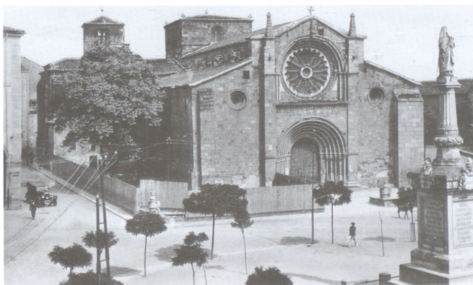
Iglesia de San Pedro en reparaciones y antigua sacristía a la izquierda. Tarjeta postal. h. 1930.
