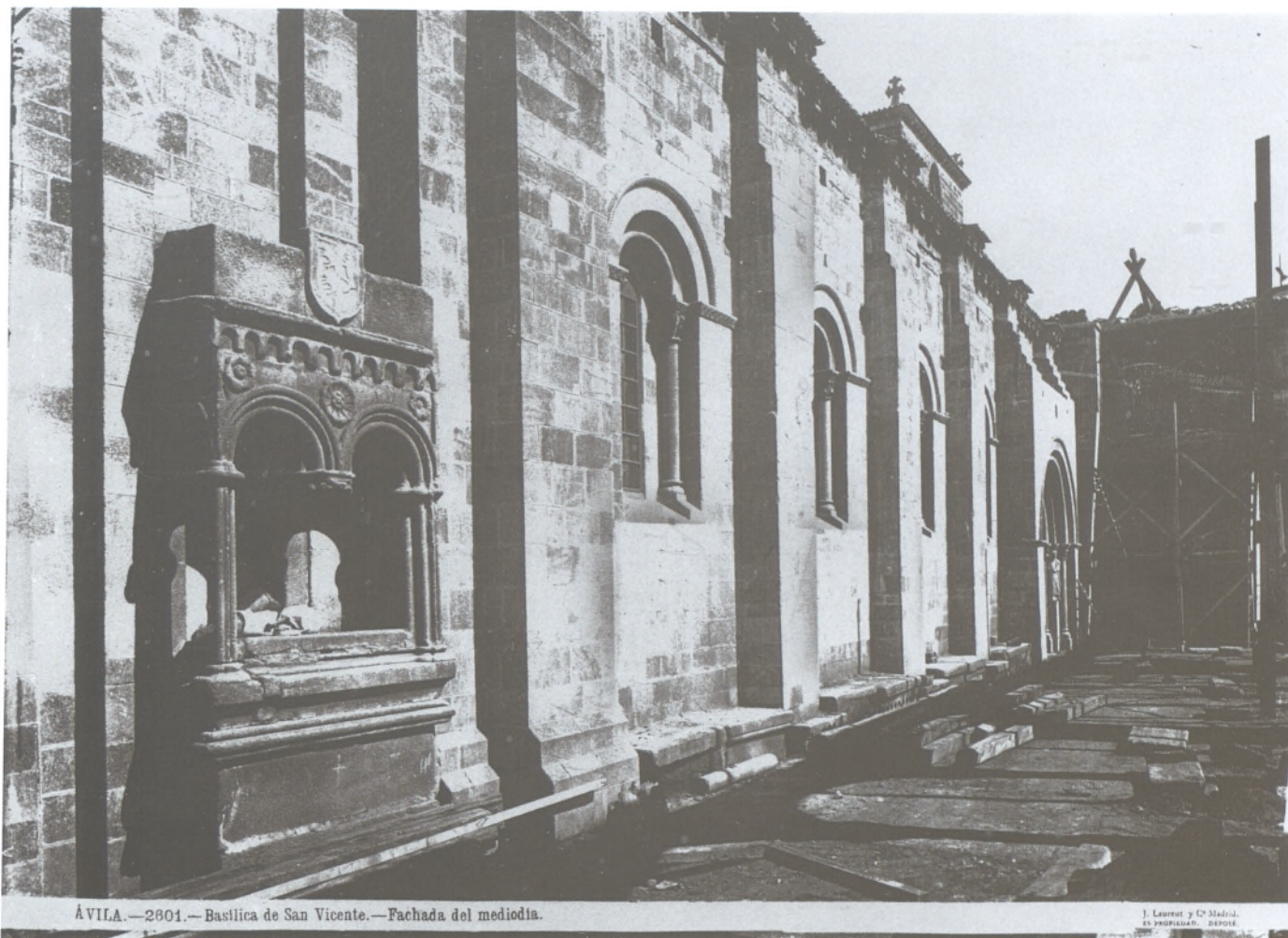
Basílica de San Vicente. Obras en el atrio. Foto: Laurent , h. 1885.
