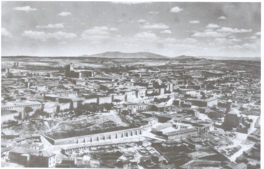
Vista aérea desde el sur. Tarjeta postal. h. 1955.
