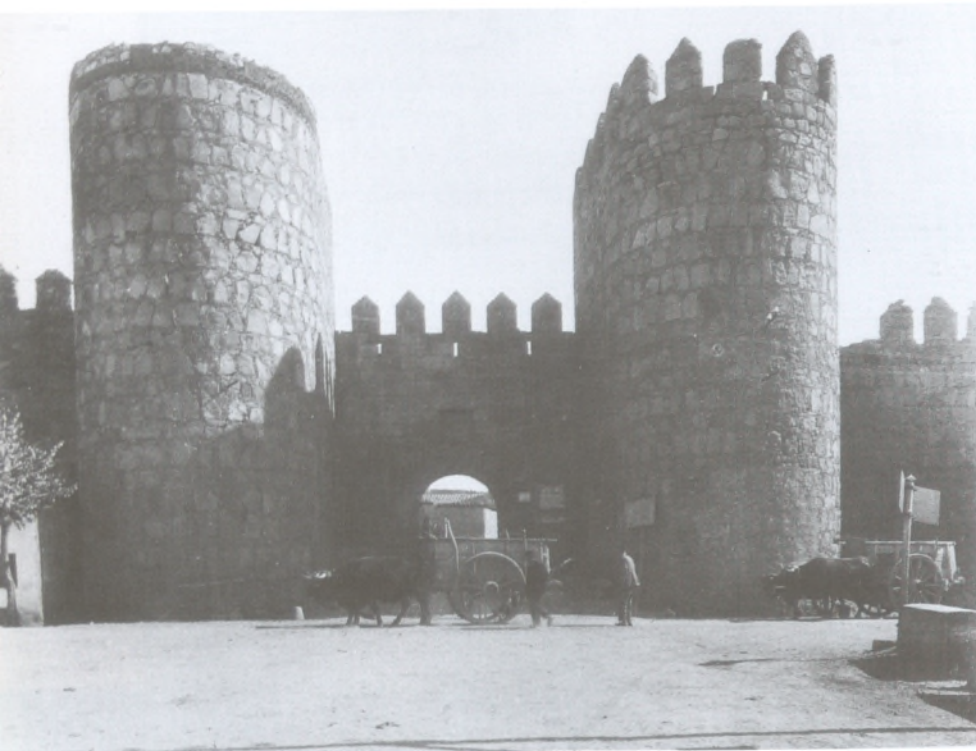
Arco del puente. Foto: Mas. 1928
