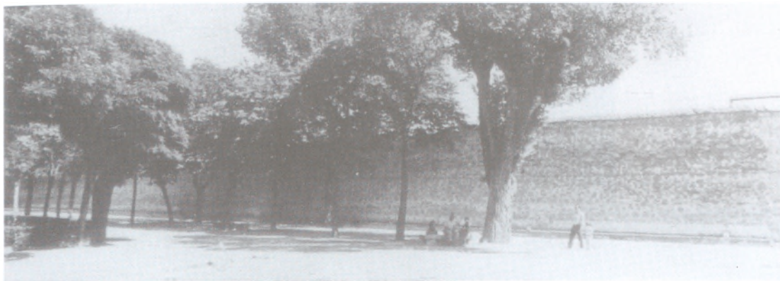
Muro del convento de Santa Ana desde el jardín del Dos de Mayo. h. 1970. Foto del libro: «Rehabilitación de Santa Ana».
