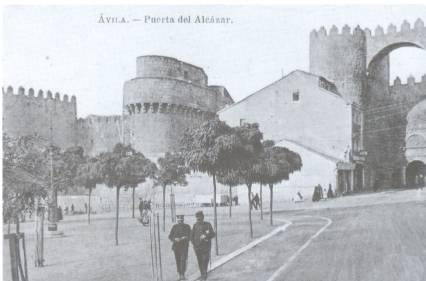
El torreón del homenaje está apuntalado y techado aún con tejas. Foto: Lacoste. h. 1910. Tarjeta postal.
