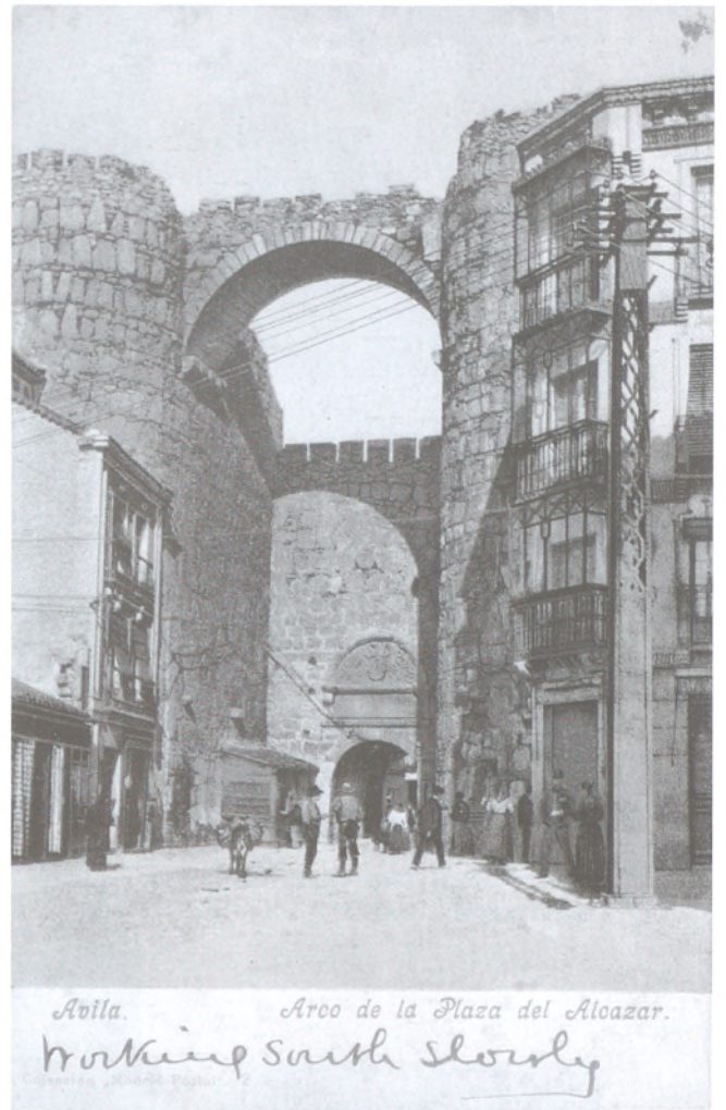
Merlones sin restaurar en el arco del Alcázar. Foto: Puger y Co. Munich. Tarjeta postal. 1901.
