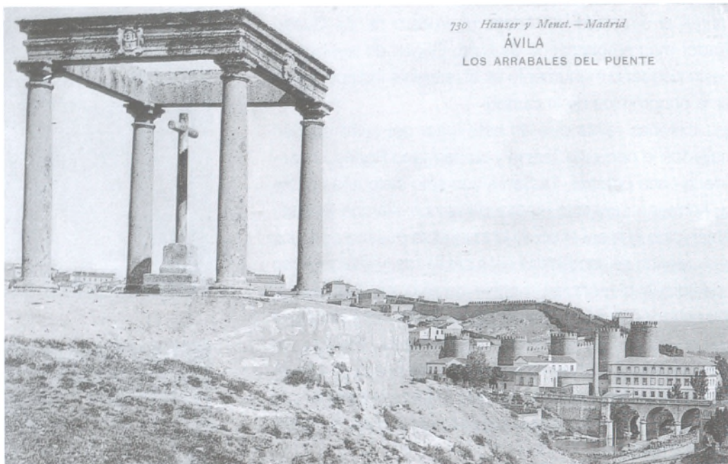
Arrabales del puente. Tarjeta postal: Hauser y Menet.h. 1910.
