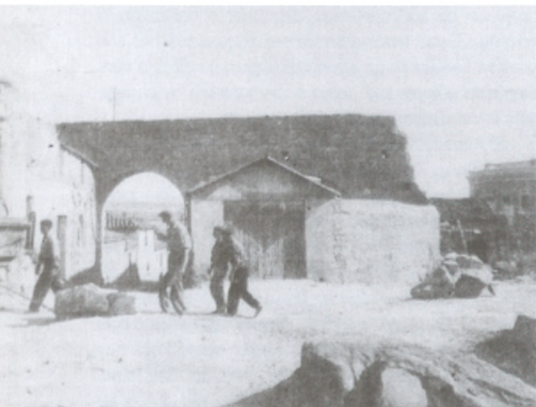
Derribo del acueducto en 1960. Foto: Mayoral .
