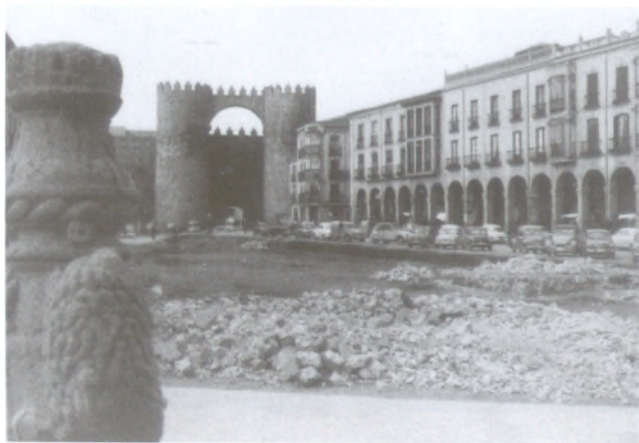
Demolición de la plaza original. 1965.
