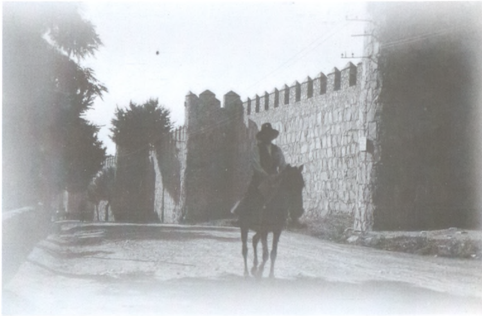
Paseo del Rastro. Foto: Loty, h. 1920.
