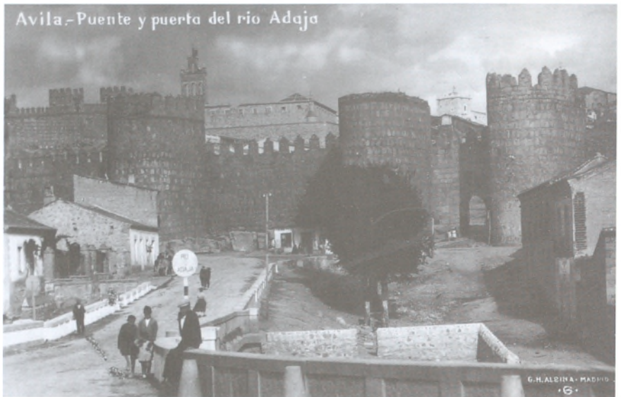
Puente Adaja. Foto: Alsina. h. 1940. Tarjeta postal.
