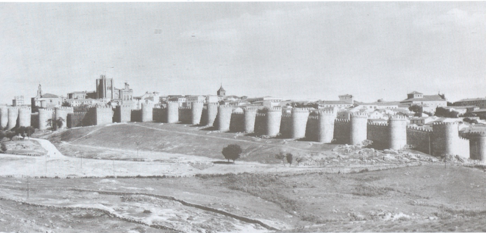
Vista parcial. Tarjeta postal. h. 1960.
