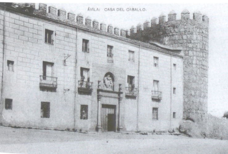
Casa del caballo en la Calle San Segundo y su tapial. Tarjeta postal. h. 1910.
