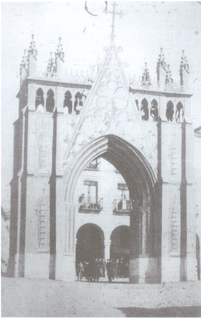
Arco neogótico en cartón piedra instalado en El Grande, proyectado por Ángel Barbero. Foto: Col. Herederos de M. Aribas.
