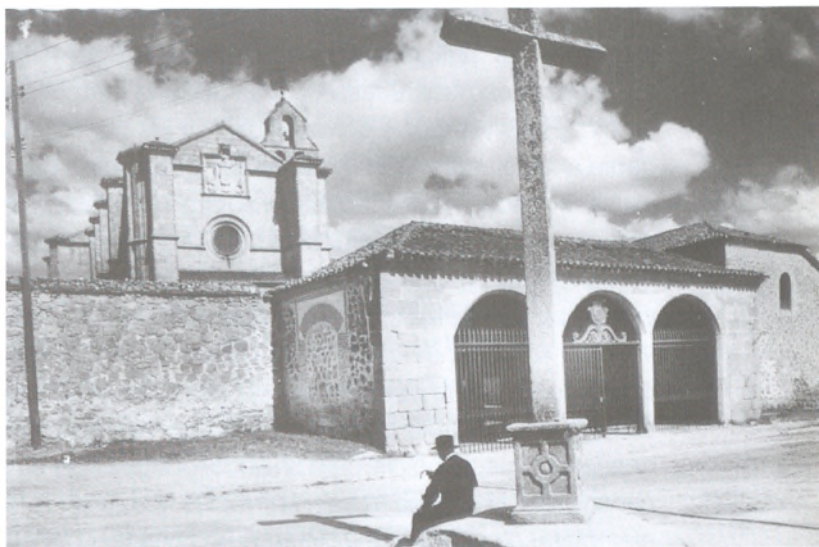
Crucero del pórtico de Santo Tomás Tarjeta postal. h. 1945.
