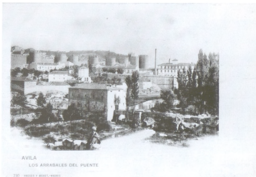
Arrabales del Puente. Tarjeta postal. Hauser y Menet. h. 1900.
