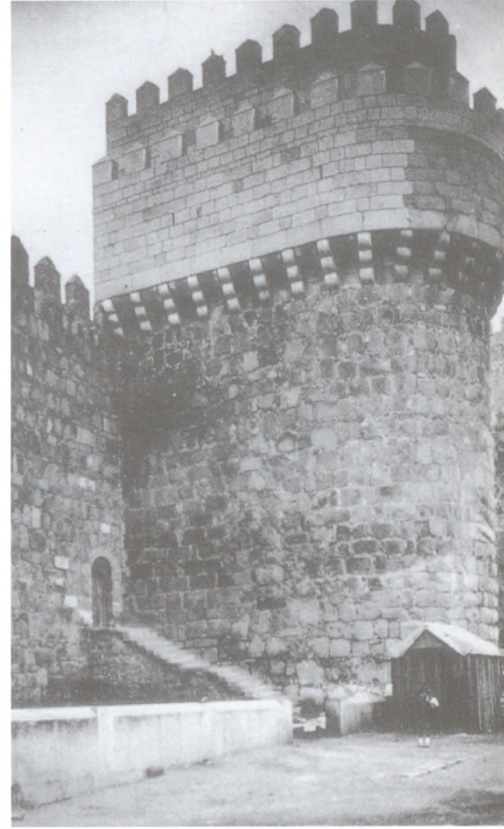
El torreón del homenaje fue restaurado hacia 1911. Las piedras nuevas, aún hoy constrostan claramente. Tarjeta postal. h. 1930.
