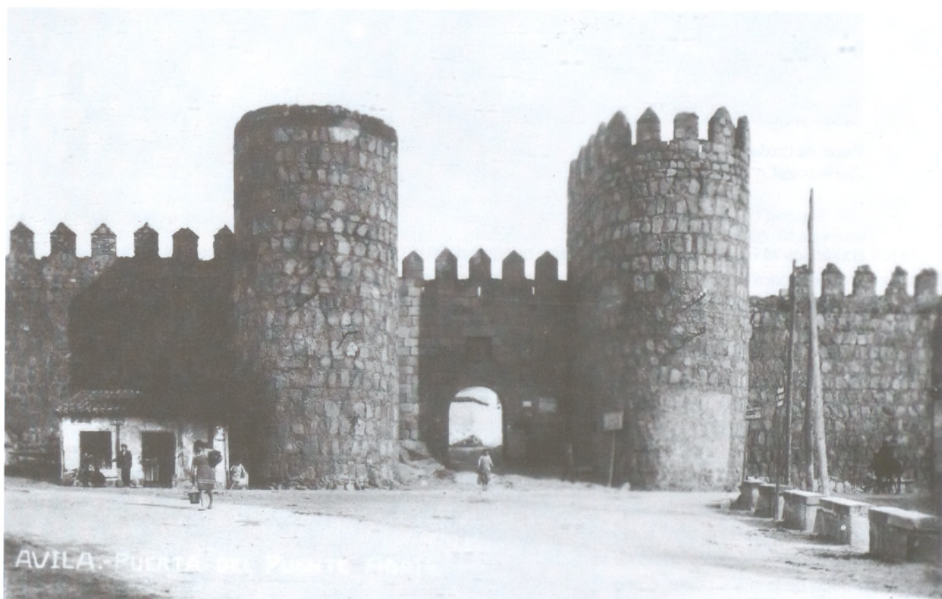
Puerta del Puente y Fielato para el pago de mercancías. Tarjeta postal. h. 1930.
