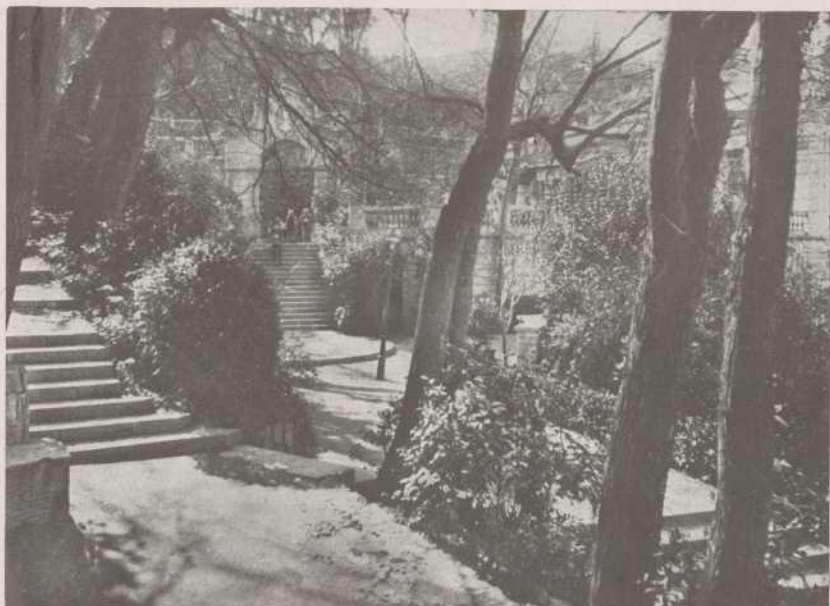
Restaurant de la "Font del Gat"
