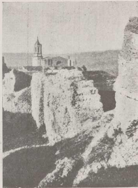
Part superior de la ciutat rodejada per murs en estat ruïnós.
