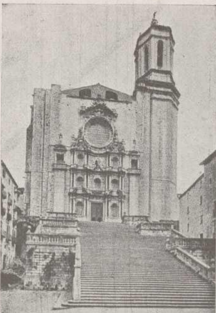
Façana principal de la Catedral
