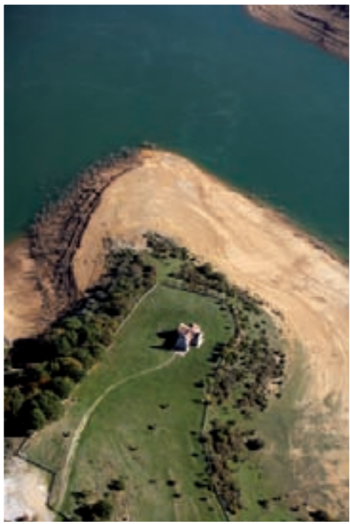
Viejas construcciones afloran en las márgenes del embalse de Riaño
