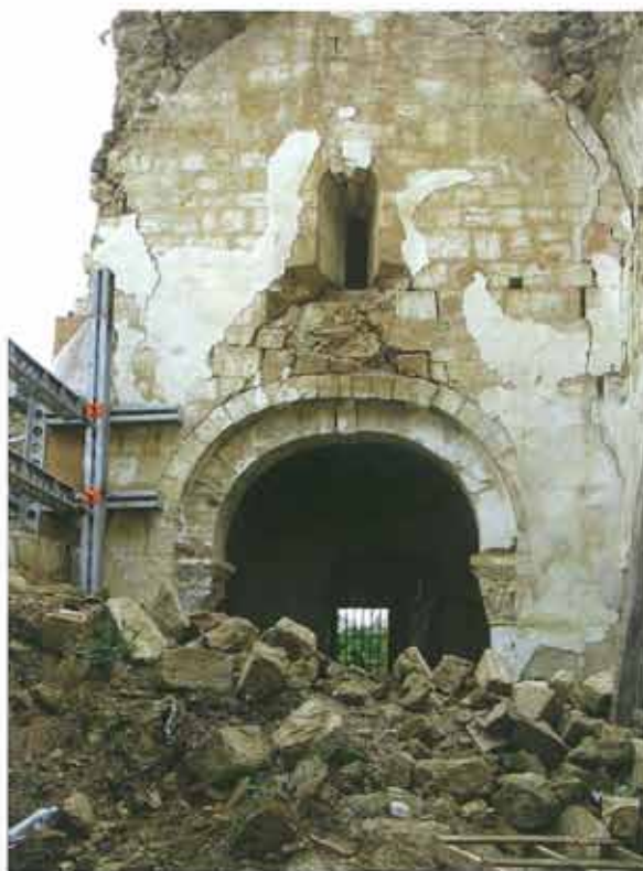
Vista de la nave central a la altura del crucero antes del desescombro
