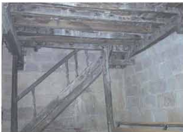
Estado previo y final de la escalera y vigería del coro, tras la restauración de las piezas dañadas y la sustitución de la escalera de acceso al mismo.
