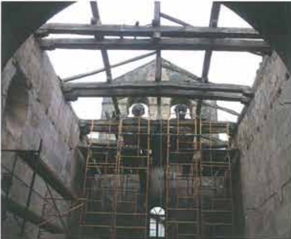
Aspecto de la estructura de la cubierta.
