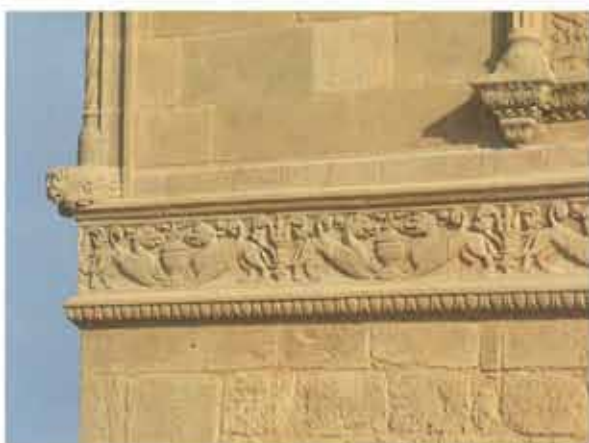
Impregnación de la piedra arenisca moteada , con lechada fluida de cal hidráulica pigmentada con tierras naturales color Siena y aglutinante de caseína
