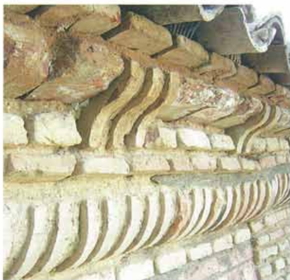
Detalle de la bella cornisa de la capilla, en la que se observan los ladrillos dispuestos de una forma rítmica, tras el rejuntado y reparación de todo el perímetro de la misma.
