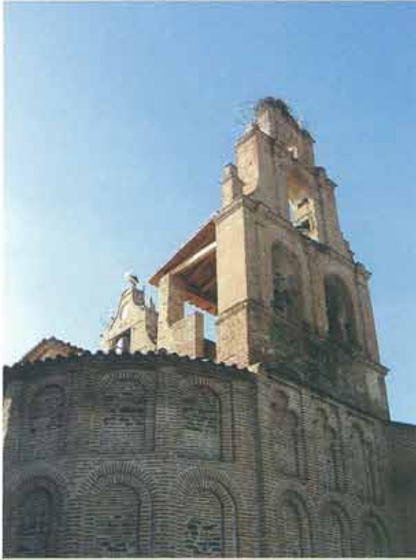
Alzado norte, ábside y espadaña en su estado final
