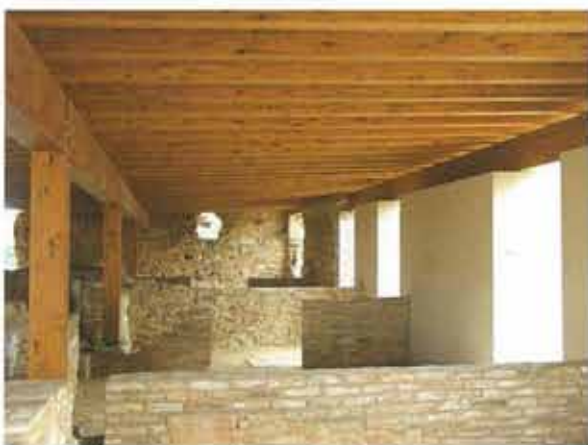
Celdas e los dormitorios consolidadas y protegidas con la cubierta, tomando como referencia el forjado antiguo
