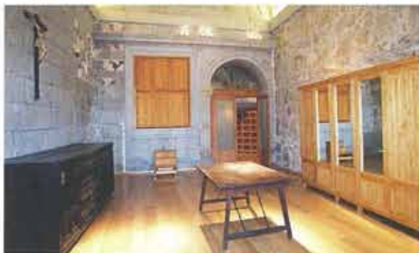
Aspecto general de la sacristía tras la colocación de la tarima de madera calefactada, mediante suelo radiante, nuevo armario y alacena, y nueva puerta de madera y cristal
