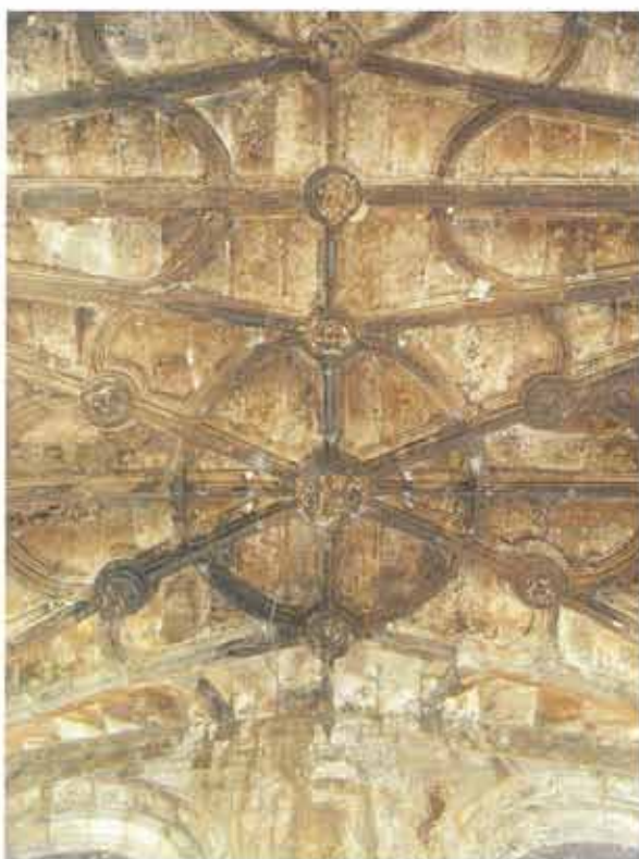
Aspecto de la bóveda de la capilla en su estado inicial
