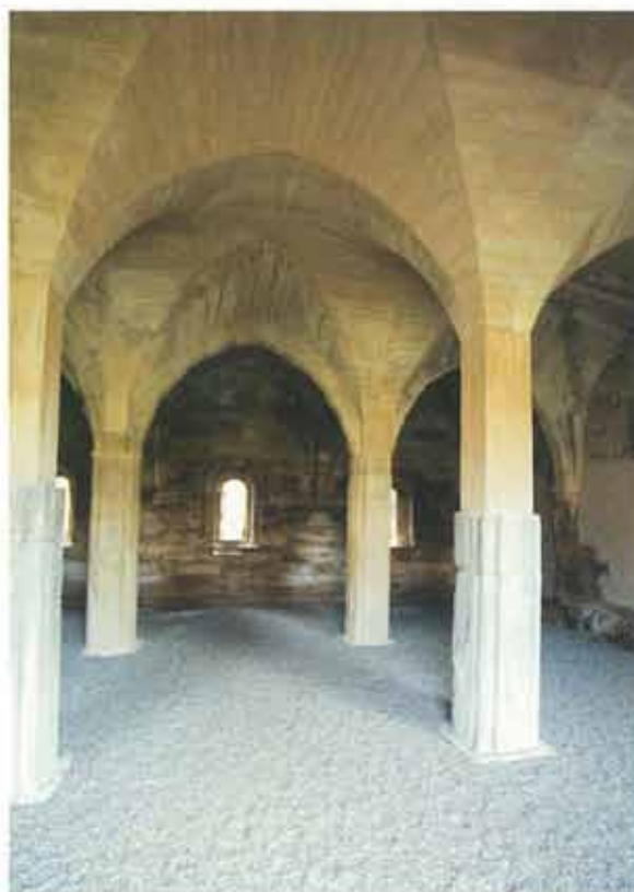
Detalle de la sala capitular una vez consolidada
