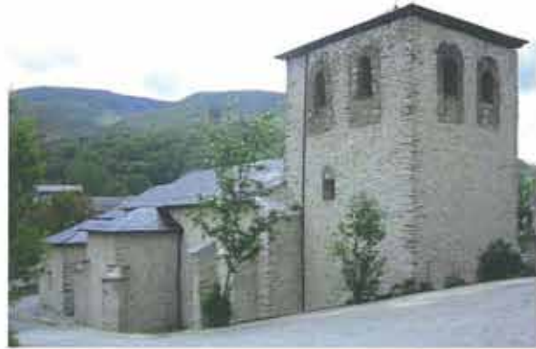
Estado final del templo
