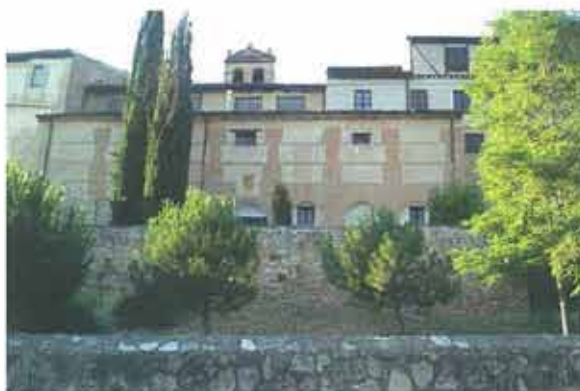
Aspecto exterior correspondiente a la ampliación en altura, en la parte superior
