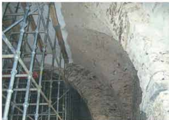
Aspecto del interior de la nave durante los trabajos de restauración
