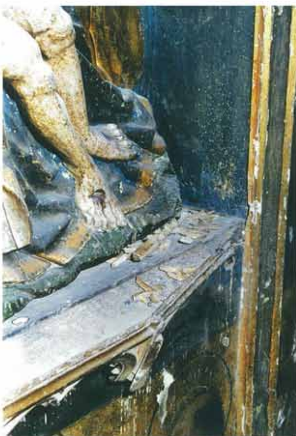
Estado inicial de una de las partes del retablo en la que se observa rotura y pérdida de piezas
