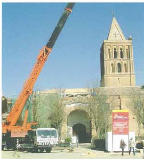
Vista general de la iglesia durante el proceso de ejecución
