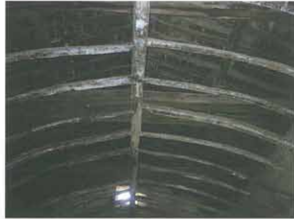
Aspecto tras el desmontaje del falso techo.
