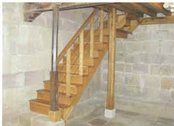
Estado previo y final de la escalera y vigería del coro, tras la restauración de las piezas dañadas y la sustitución de la escalera de acceso al mismo.
