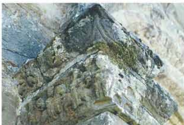
Biodeterioro. Exfoliación y pérdida de material en uno de los capiteles en el que se representan los tres Reyes Magos cabaigando.
