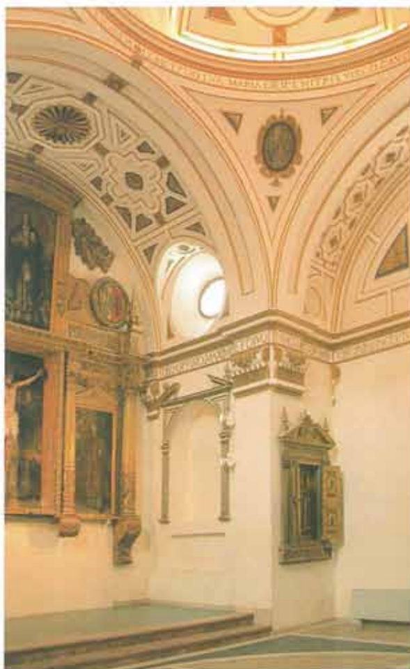
Cabecera de la capilla, muro este, después de la intervención
