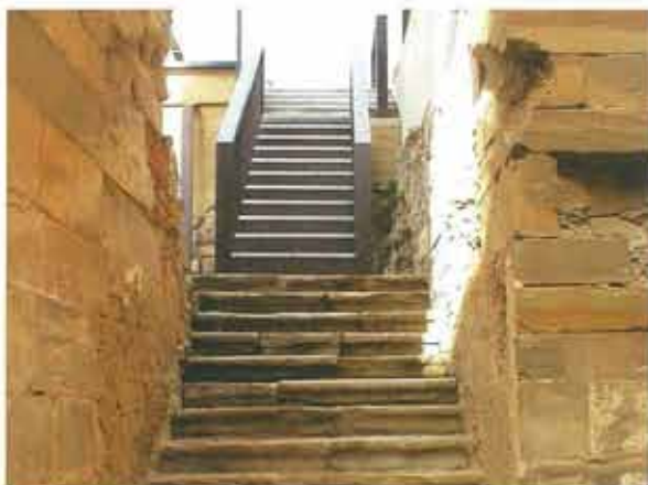
Escalera de comunicación entre la iglesia y el dormitorio de monjes una vez recuperada
