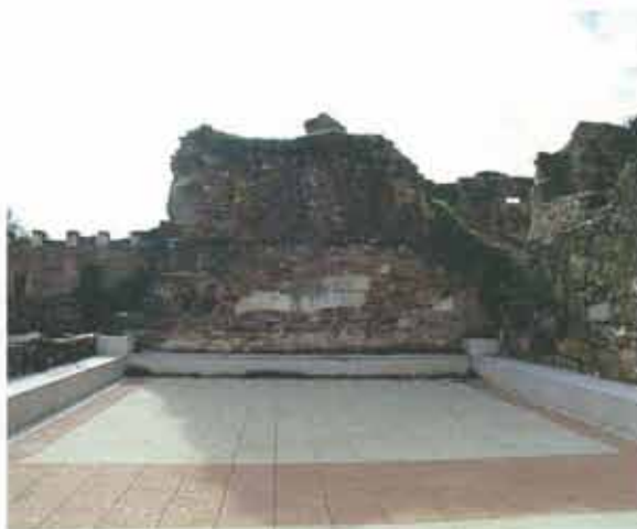
Biblioteca una vez recuperada y con las estructuras protegidas
