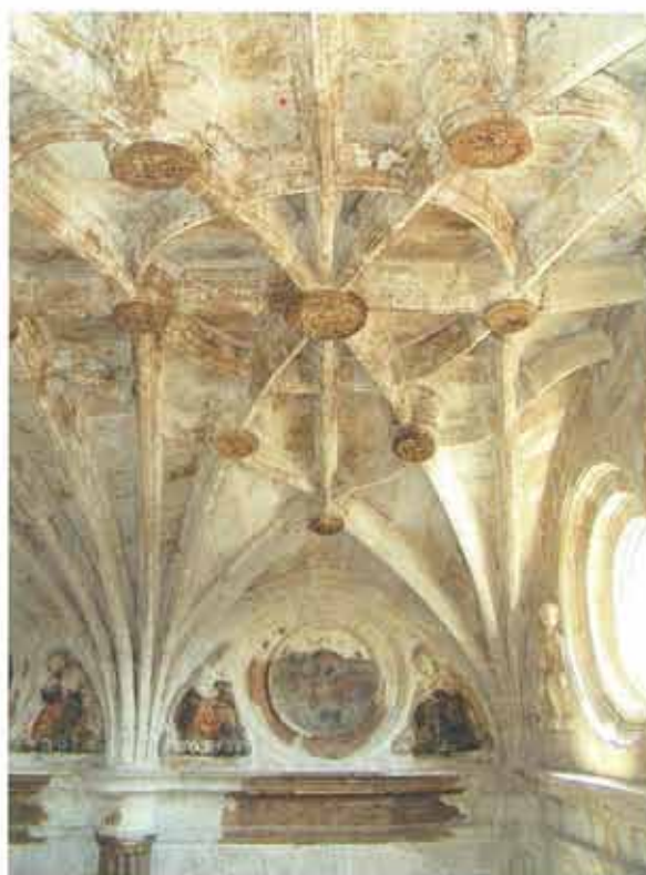
Bóveda de la capilla en su estado final
