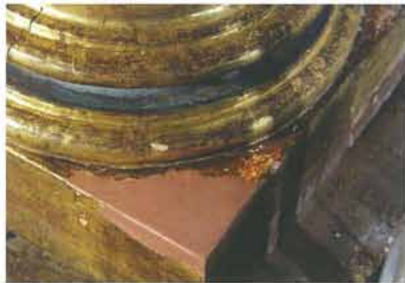
Estado inicial y reintegración volumétrica de uno de los elementos arquitectónicos.
