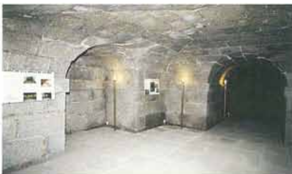
Aspecto del interior de la cripta, tras la limpieza y rejuntado de la sillaría y la colocación de los paneles informativos
