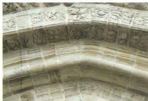
Estado inicial y final de las dos primeras arquivoltas de la portada. A la izquierda, eliminación del rejuntado y acuñación con piezas de madera para evitar los posibles movimientos, y favorecer la fijación de los nuevos rejuntadazos
