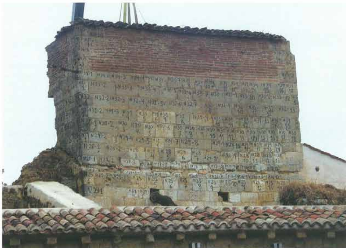
Vista de la cara sur del falso cimborrio, una vez realizado su siglado y antes de comenzar su desmonte
