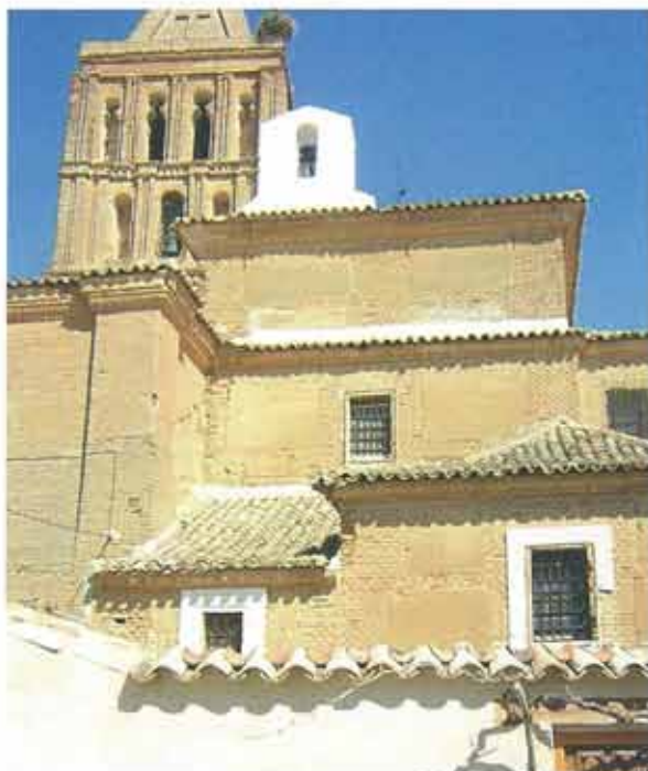
Aspecto general de las cubiertas de la iglesia tras la restauración
