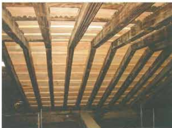
Detalle del interior de la nave durante la intervención
