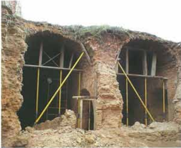
Interior de la botica durante su recuperación
