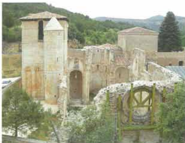
Aspecto final del Monasterio tras las obras de consolidación
