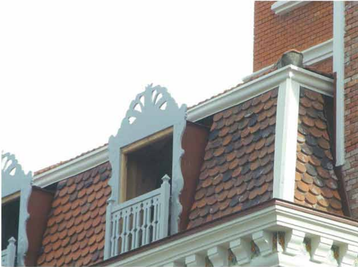
Detalle de la fachada después de su restauración. La fábrica de ladrillo ha sido sometida a una limpieza no exhaustiva. Las molduras y demás elementos decorativos han sido reproducidos con el patrón original.
