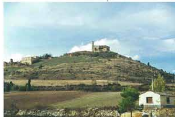
Vista del emplazamiento de la iglesia desde Encío
