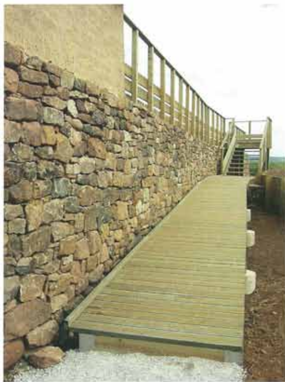
Detalle del acceso a la reconstrucción del muro y torres de la muralla celtibérica
