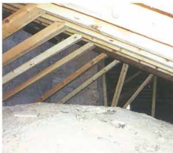
Detalle del proceso de intervención en la cubierta
