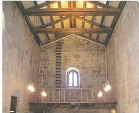
Estado final de la estructura de madera de la nave, tras la sustitución de la vigería y entramado.
