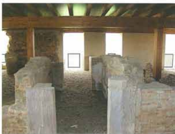
Celdas e los dormitorios consolidadas y protegidas con la cubierta, tomando como referencia el forjado antiguo
