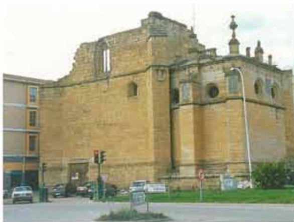
Estado previo del entorno inmediato al Convento de San Francisco, en el que aparece un aparcamiento de vehículos, agresivo al monumento y degradante al entorno urbano
