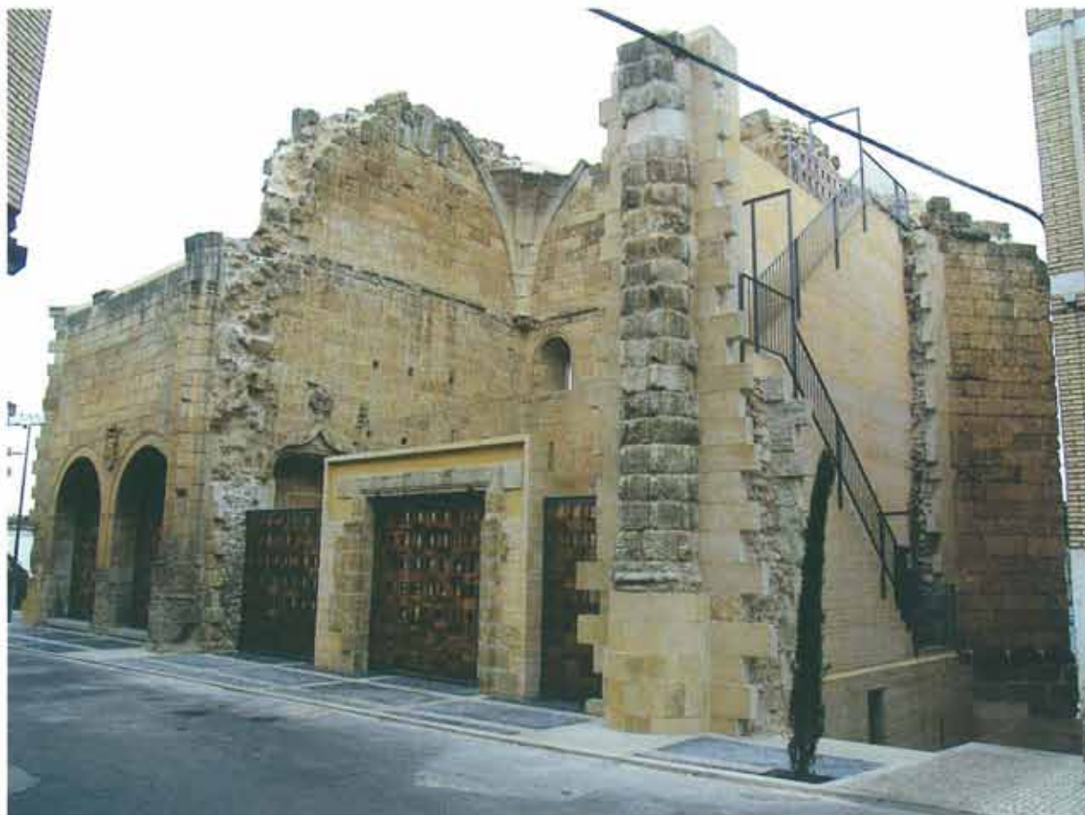
Aspecto del exterior de las ruinas del convento de San Francisco tras la intervención
