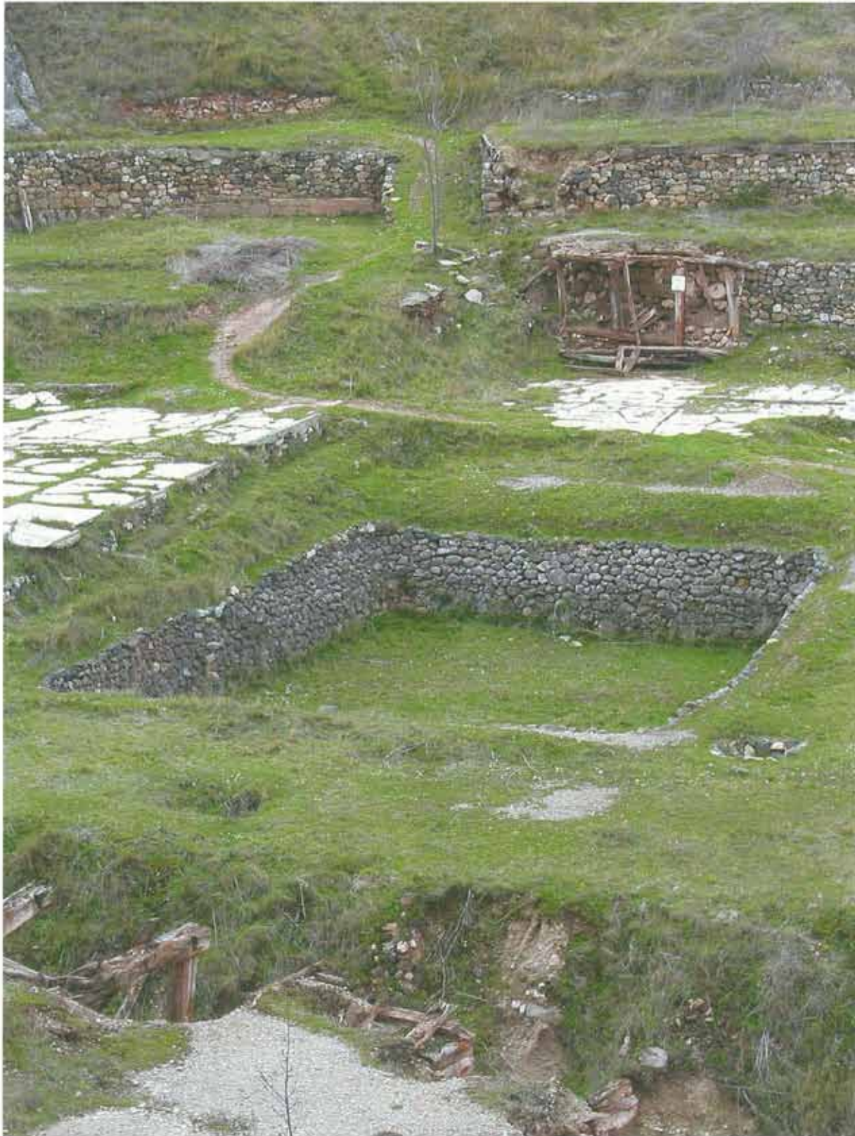
El esplendor de la villa de Poza se debía a sus famosas salinas, conocidas desde el Neolítico y explotadas intensivamente por los romanos. La producción de la sal se realizaba conduciendo el agua salada que se extraía de los manantiales naturales por una red de acueductos, hasta unas plataformas horizontales, en las que el agua se repartía en parcelas rectangulares. La evaporación del agua dejaba la sal preparada para su recolección, que de allí pasaba a unos depósitos o almacenes, para su posterior comercialización
