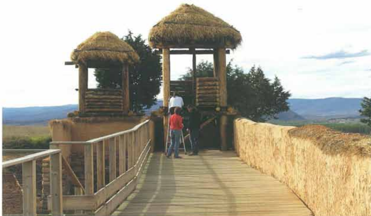
El levantamiento de estas estructuras correspondientes al sistema amurallado de la fase indígena permite completar la visita pública en un sector en el que las estructuras visibles eran prácticamente inexistentes.
