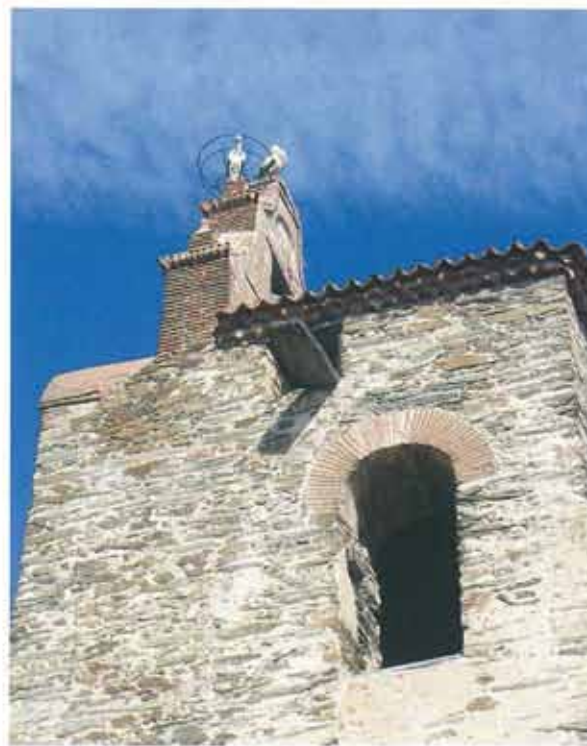
A la izquierda, detalle de la torre en su estado previo en donde se aprecia una grieta en la cara sur; apertura del arco del hueco, desprendimiento de su clave y destrabazón de la mampostería. A la derecha, el mismo detalle en su estado final
