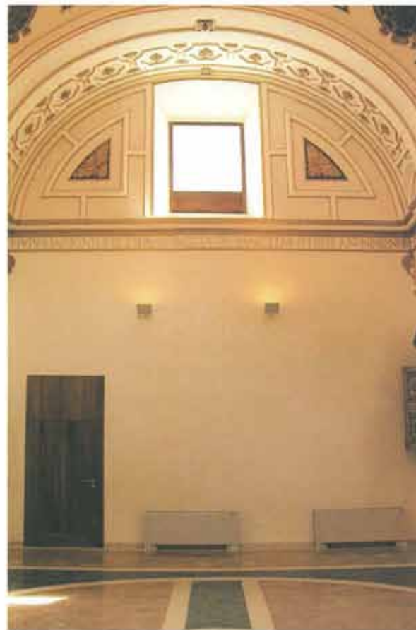
Interior de la capilla, muro norte, antes y después de la intervención.
