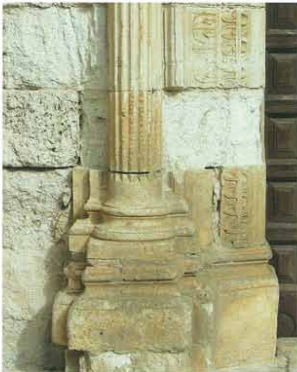
Estado inicial de la jamba
