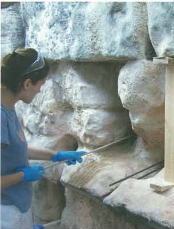
Tratamiento vaciado. Recalco
