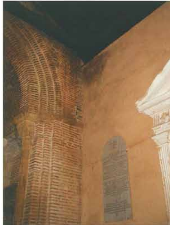
Aspecto del interior de la nave en el encuentro del muro sur con el muro del presbiterio, tras la reciente restauración
