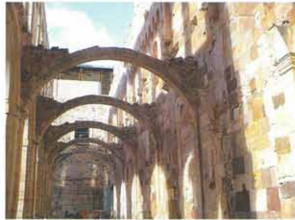
Aspecto final del claustro procesional una vez intervenida la zona.
