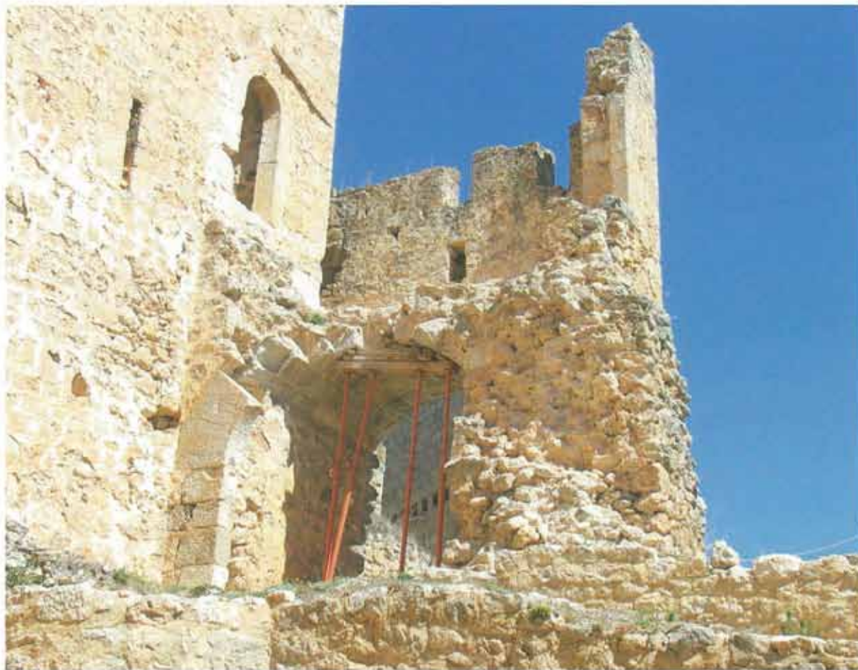
Detalle del estado de conservación de una de las zonas del castillo
