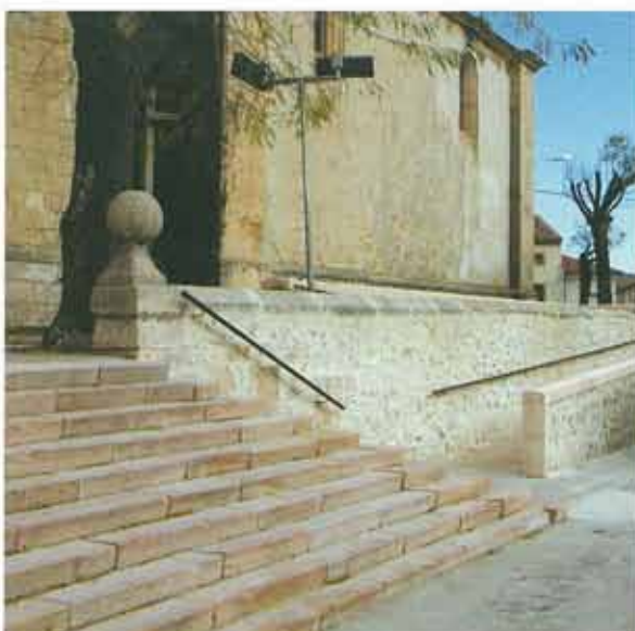
Detalles de la rampa de acceso para facilitar el acceso al templo. Su construcción, perfectamente integrada en el conjunto, ha sido ejecutada con muros de hormigón y recubrimiento exterior de lajas de piedra caliza rosa, barandillas, acabado en el interior en hormigón abujardado, y solado de piedra caliza rosa, tipo Sepúlveda, como la empleada en el edificio
