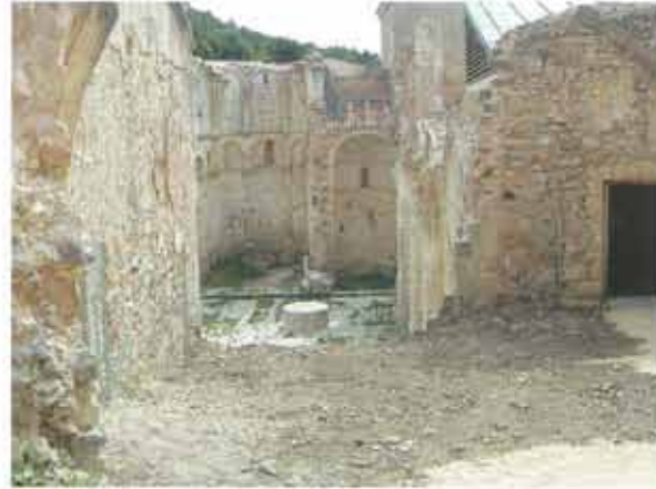
Estado final de la zona intervenida, tras la consolidación y restauración de los muros, y con la colocación de los elementos de protección adecuados.
