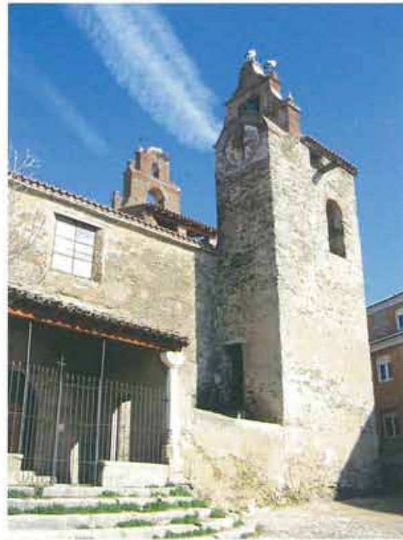
Aspecto general del alzado sur de la iglesia y torre del reloj tras la intervención
