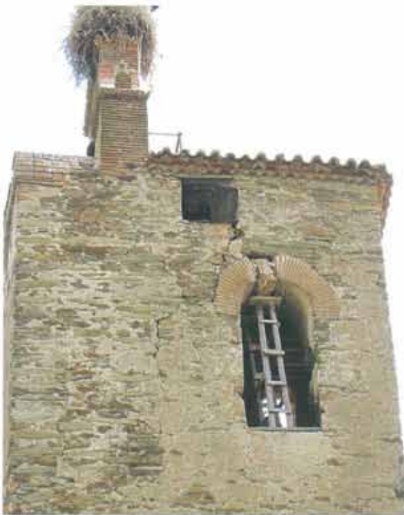
A la izquierda, detalle de la torre en su estado previo en donde se aprecia una grieta en la cara sur; apertura del arco del hueco, desprendimiento de su clave y destrabazón de la mampostería. A la derecha, el mismo detalle en su estado final
