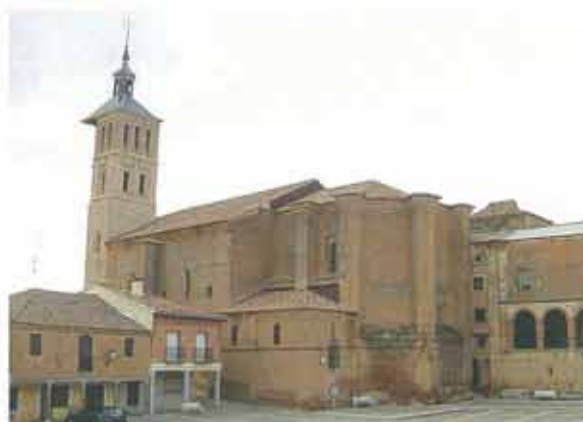
Aspecto general de la iglesia de San Miguel y del Palacio de los Condes de Grajal, desde la plaza Pedro Galla, en la que se aprecia el peculiar perfil de la torre.
