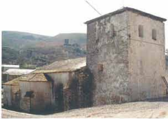
Estado previo a la restauración
