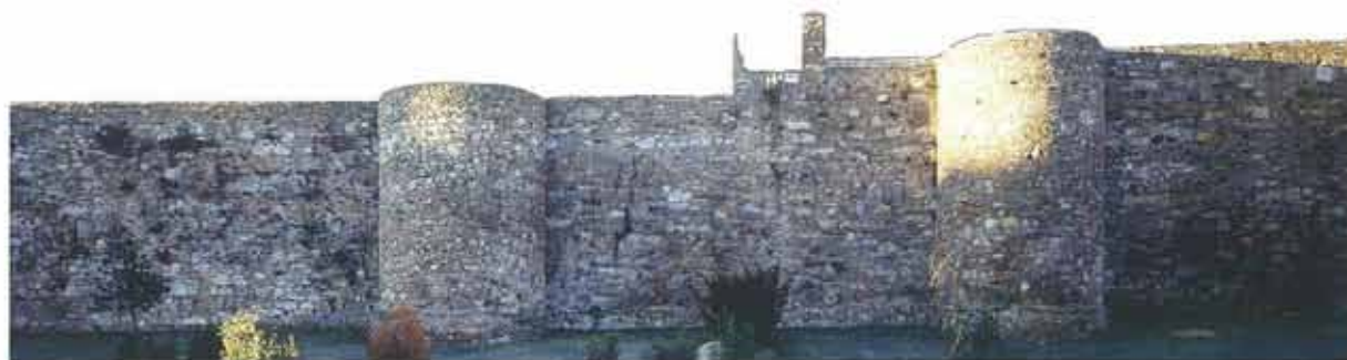
Detalle del tramo 01 de la muralla
