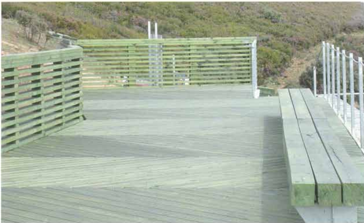
Detalle del mirador de Orellán tras la ampliación y reparación del mismo
