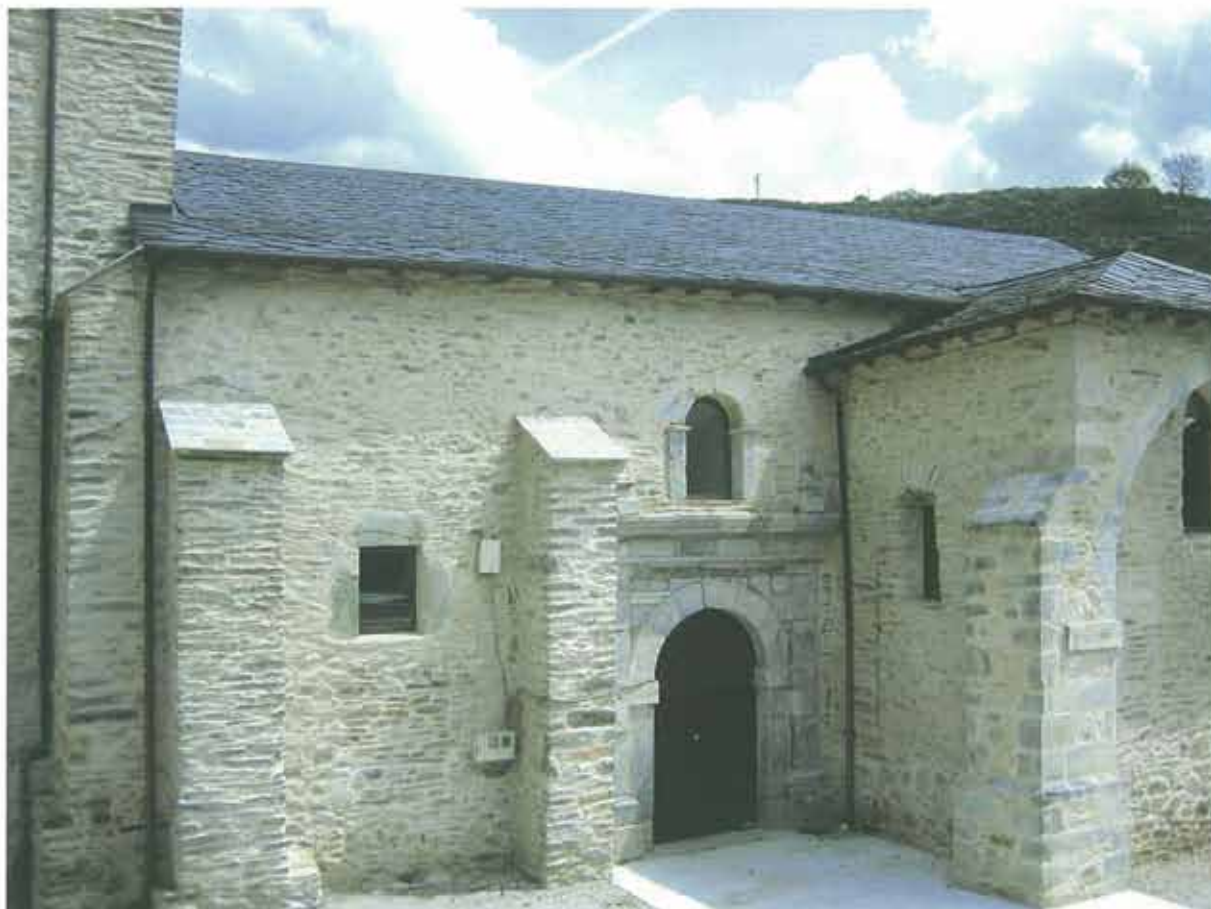
Aspecto final del templo tras las obras de restauración
