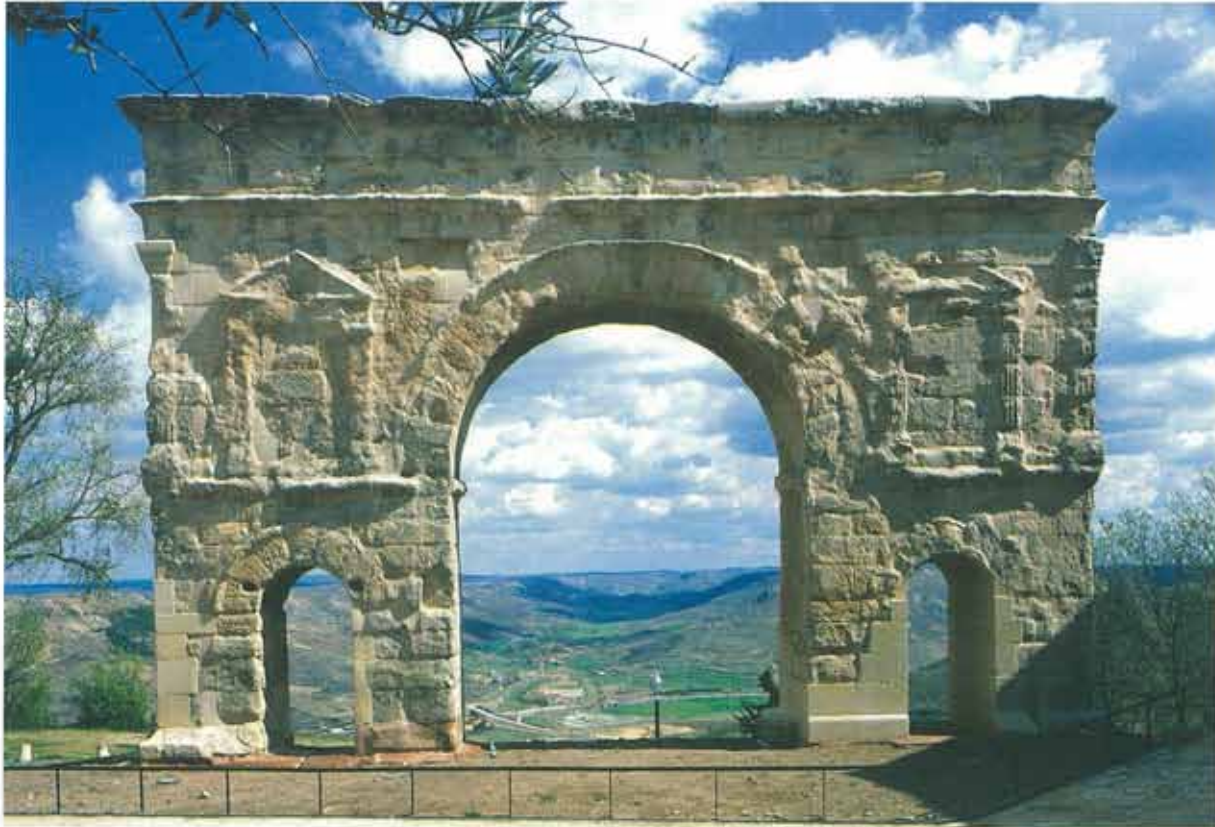
Aspecto general del arco tras la intervención
