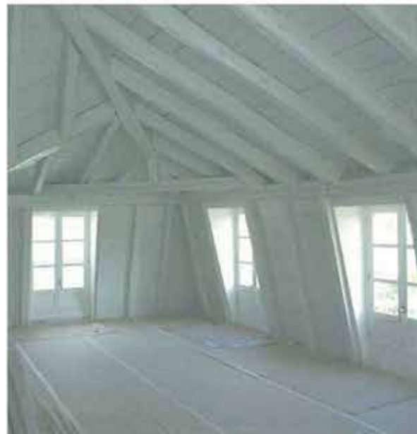
Aspecto del interior de la planta bajo cubierta, que se ha dejado diáfana y en la que se ha conservado la armadura original.
