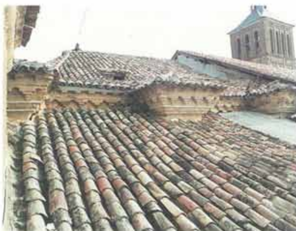
Estado previo de la zona del faldón del cuerpo de la tribuna, junto al presbiterio, que ocultaba las pinturas del friso.
