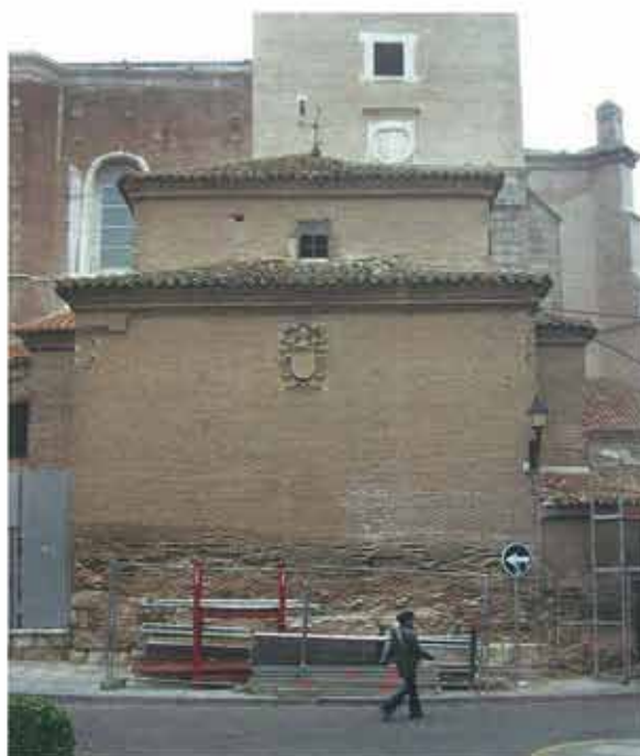
Exterior de la capilla Quiñones al inicio de los trabajos de restauración
