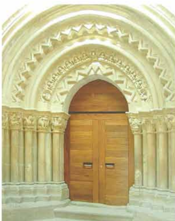
Aspecto, tras la restauración, de la portada románica de acceso, formada por seis arquivoltas de medio punto, en la que alternan molduras curvas con decoraciones angulares sencillas, que apoyan en columnas monolíticas con sus correspondientes capiteles.
