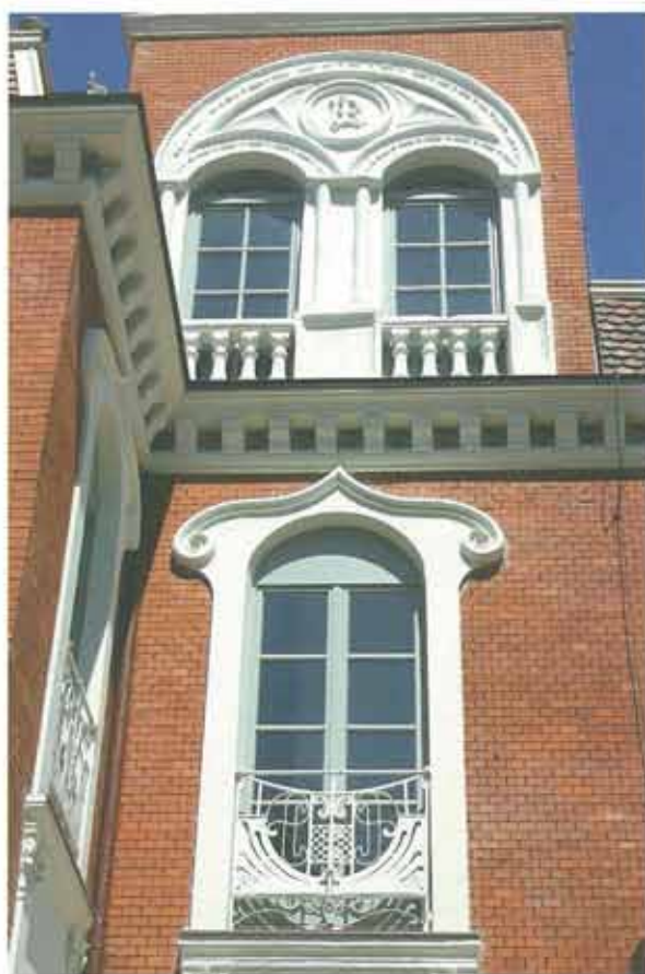
Detalle de una de las fachadas en la que destacan elementos medievales, renacentistas y modernistas, éstos últimos destacables en el antepecho de hierro, en los que las líneas lático aparecen de forma destacada. En el medallón central sobresalen las iniciales de su propietario, Rufo Luelmo.
