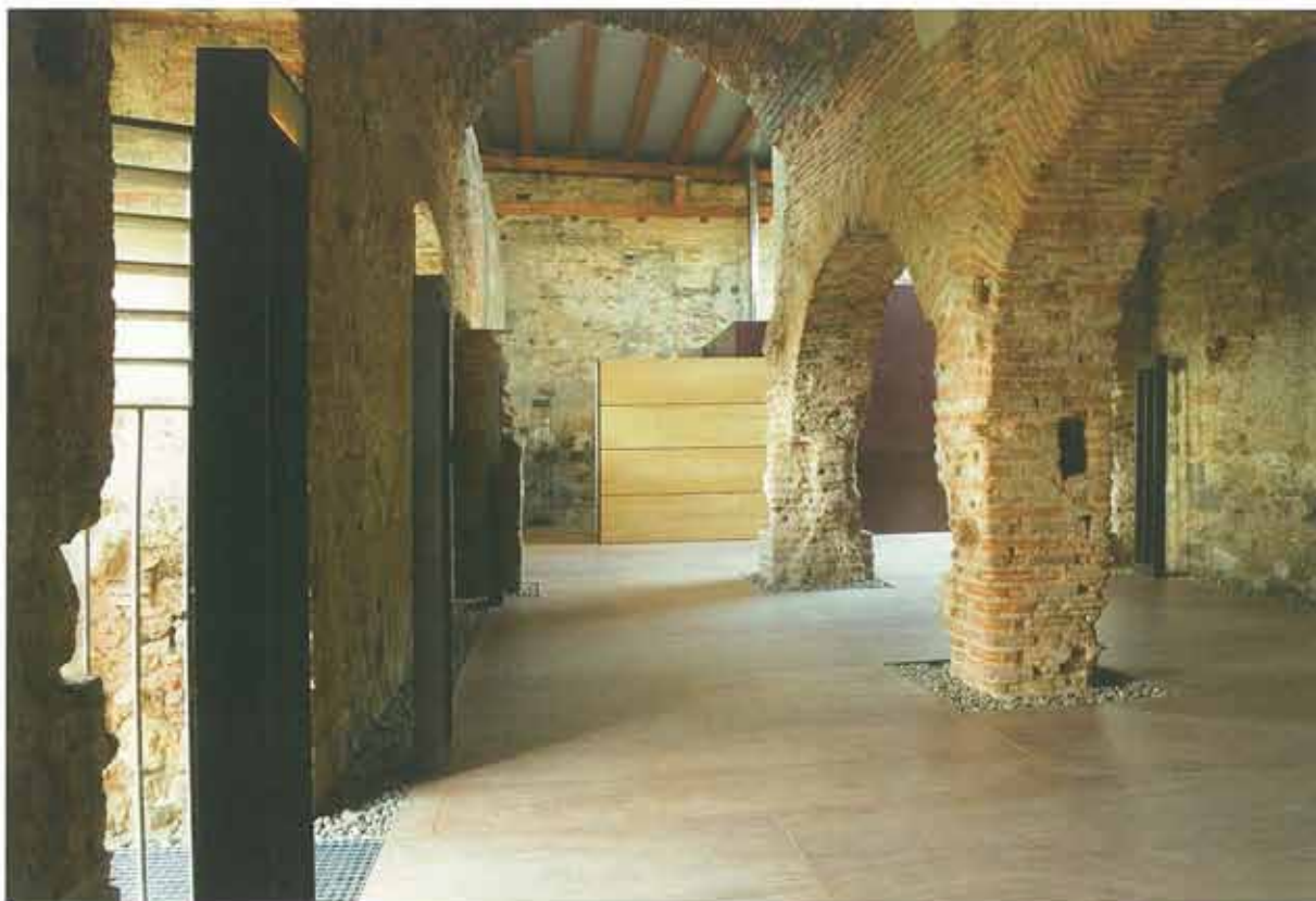
Interior de la botica una vez concluidos los trabajos. Al fondo, los servicios sanitarios
