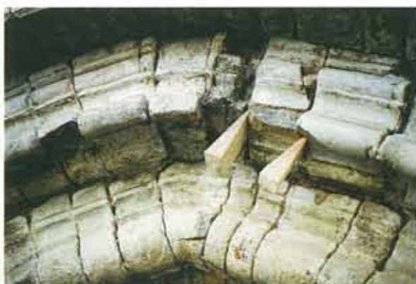
Estado inicial y final de las dos primeras arquivoltas de la portada. A la izquierda, eliminación del rejuntado y acuñación con piezas de madera para evitar los posibles movimientos, y favorecer la fijación de los nuevos rejuntadazos
