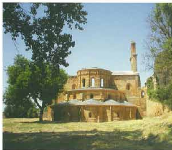
Vista exterior de la cabecera de Monasterio una vez restaurada con el cambio de cubierta
