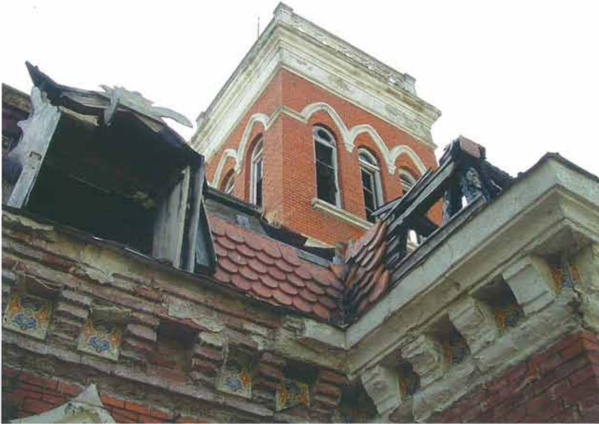
Vista de la vivienda en su estado previo
