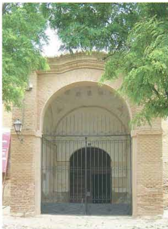
Detalle de la portada, abierta en el lado de la epístola, protegida por un soportal cubierto con bóveda de arista, y cerrado por una elevada cancela de hierro forjado. En ella se observa, tras la restauración, el rejuntado y la reposición del ladrillo deteriorado de los paramentos, el intradós del arco, una vez enfoscado y pintado, y por último, la bóveda y los muros laterales, después de la limpieza.
