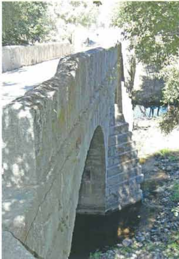
Vista del Puente de La Malena una vez limpio y consolidado
