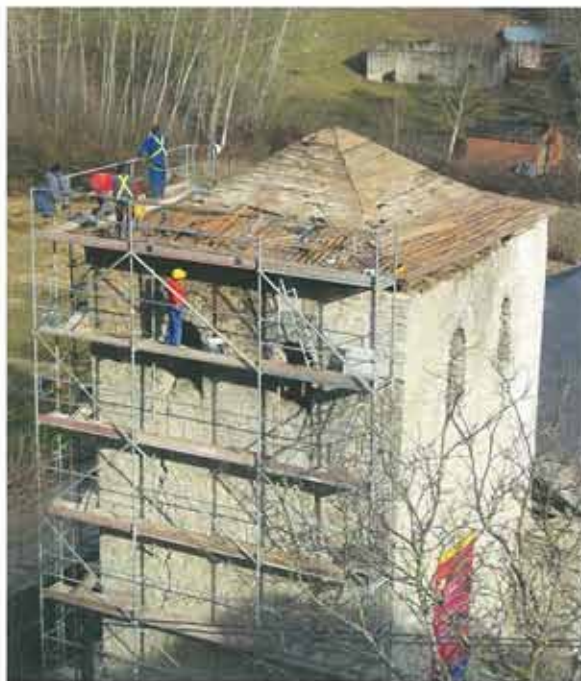
Aspecto de la torre durante los trabajos de restauración
