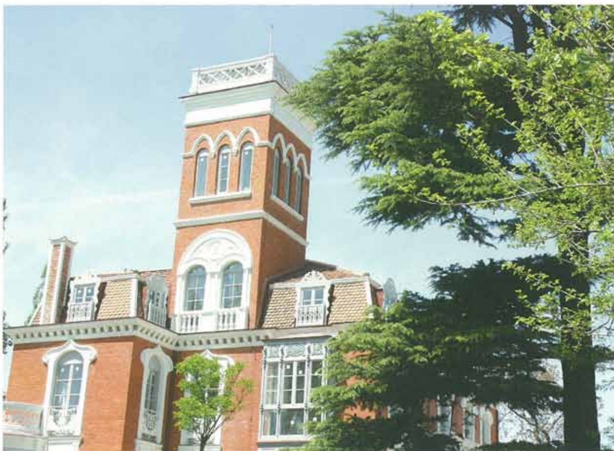
Vista general de la vivienda, promovida su rehabilitación por la Dirección General de Patrimonio y Bienes Culturales
