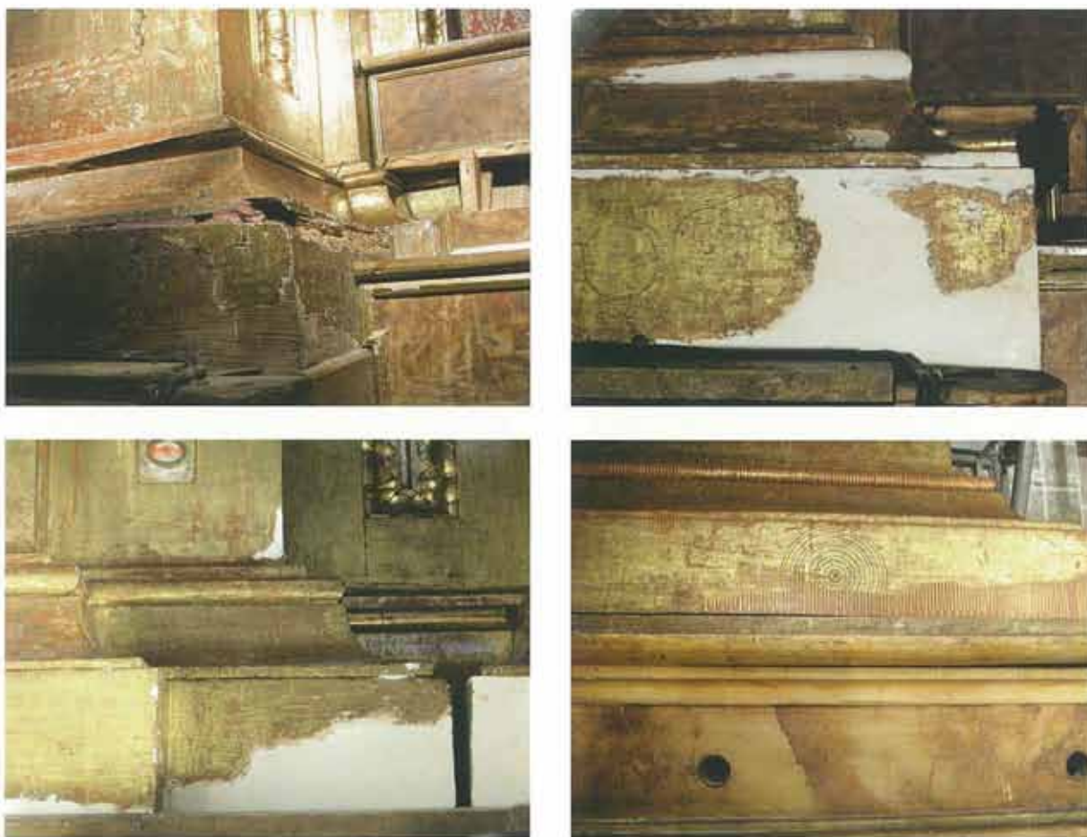
Detalles del proceso de intervención desde el estado previo al estado final
