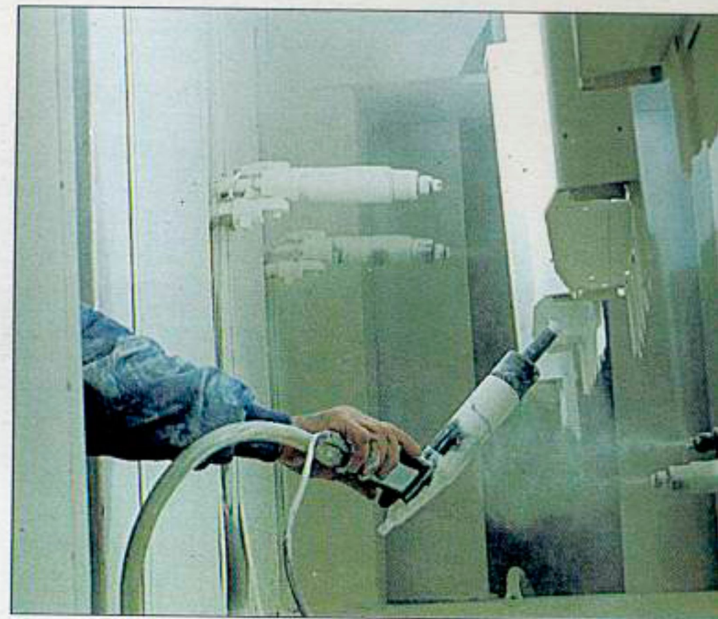
Túnel de pintura epoxi
