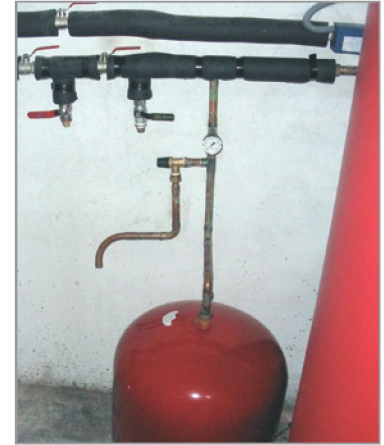
Vaso de expansión cerrado. Instalación en ejecución
