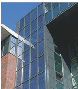
Integración arquitectónica de módulos en fachada
