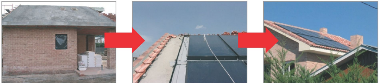
Integración arquitectónica de captadores solares térmicos
