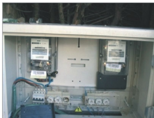
Contadores de entrada y salida y protecciones de una instalación de potencia 7,5 kW
