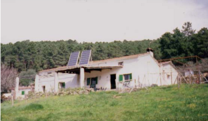
Módulos solares fotovoltaicos
